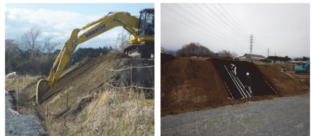
図-1 法面での刃先精度検証の試験
