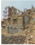
ネパール地震における被害状況
