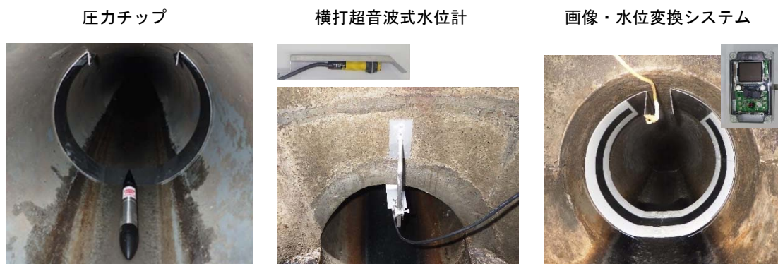
図 6-2 本実証研究における水位計測の状況
