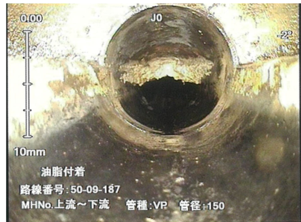
10 油脂の付着 (硬質塩化ビニル管の例)
