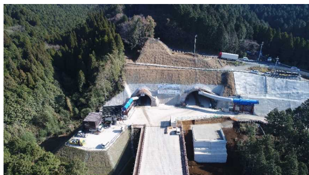
写真-3-2 二重峠トンネル
