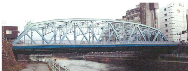
写真-3-3 犀川大橋
