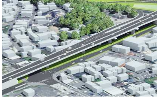
図-3-10 八坂高架橋
