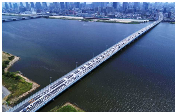
写真-3-1 淀川大橋
