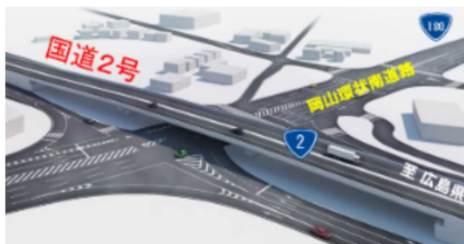
図-3-7 大樋橋西高架橋
