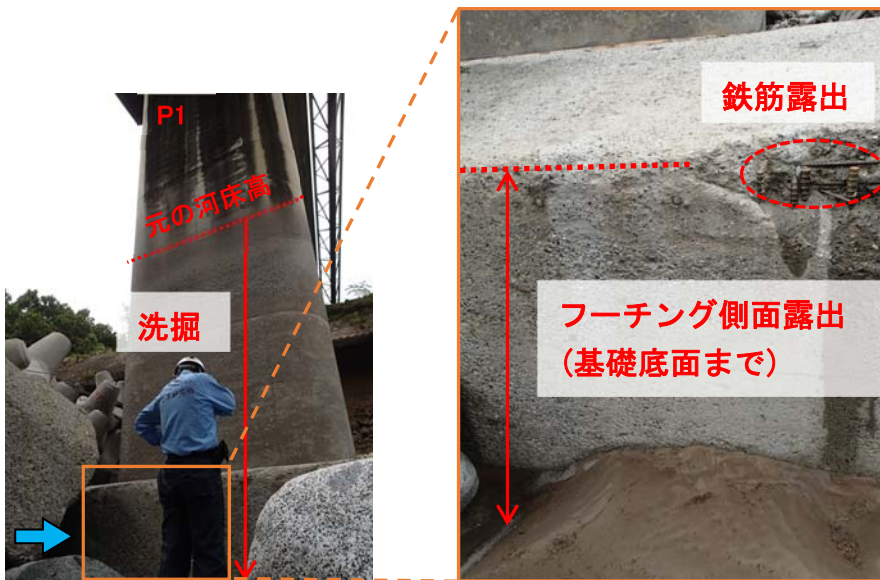
写真 5-14 P1 橋脚基礎底面の露出
