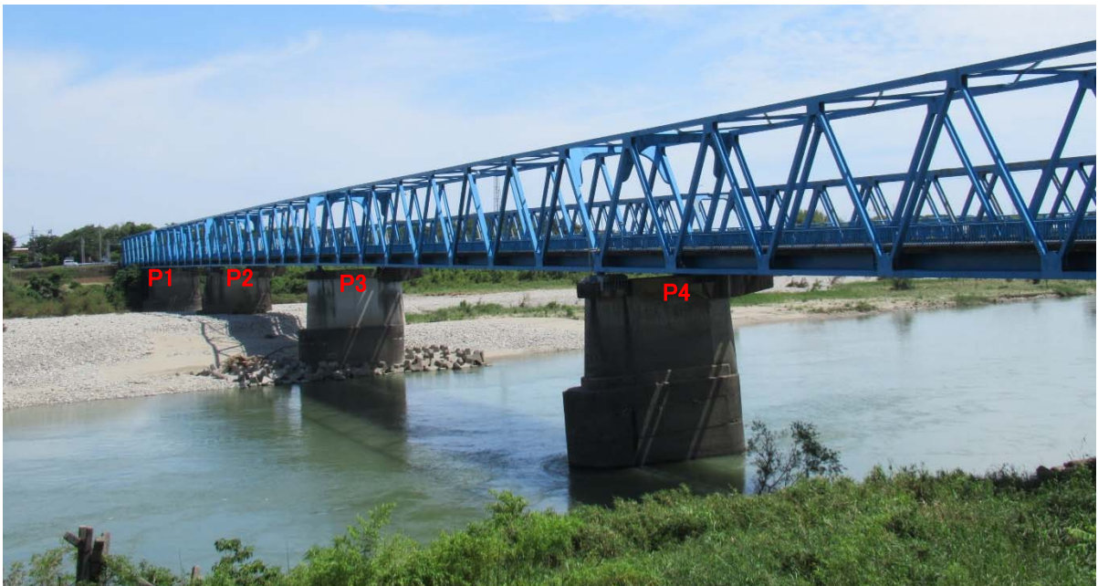
写真 5-5 被災時の砂州の状況
