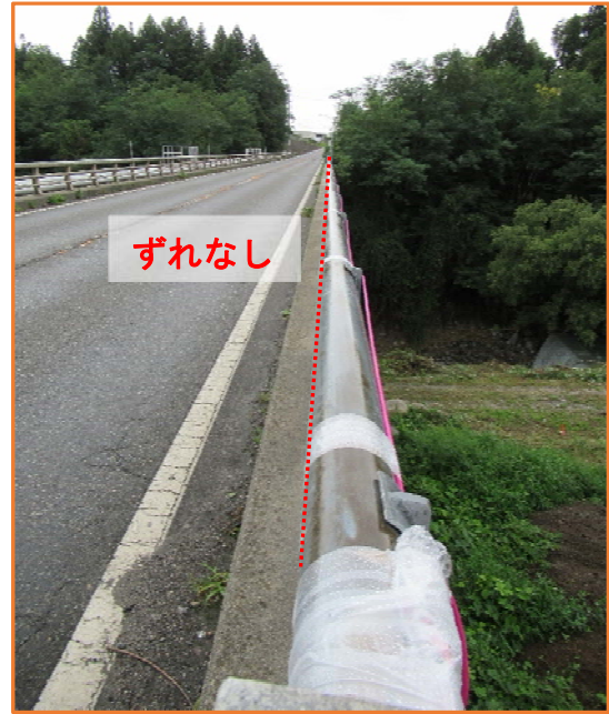
写真 5-15 被災後の橋梁上面の状況
