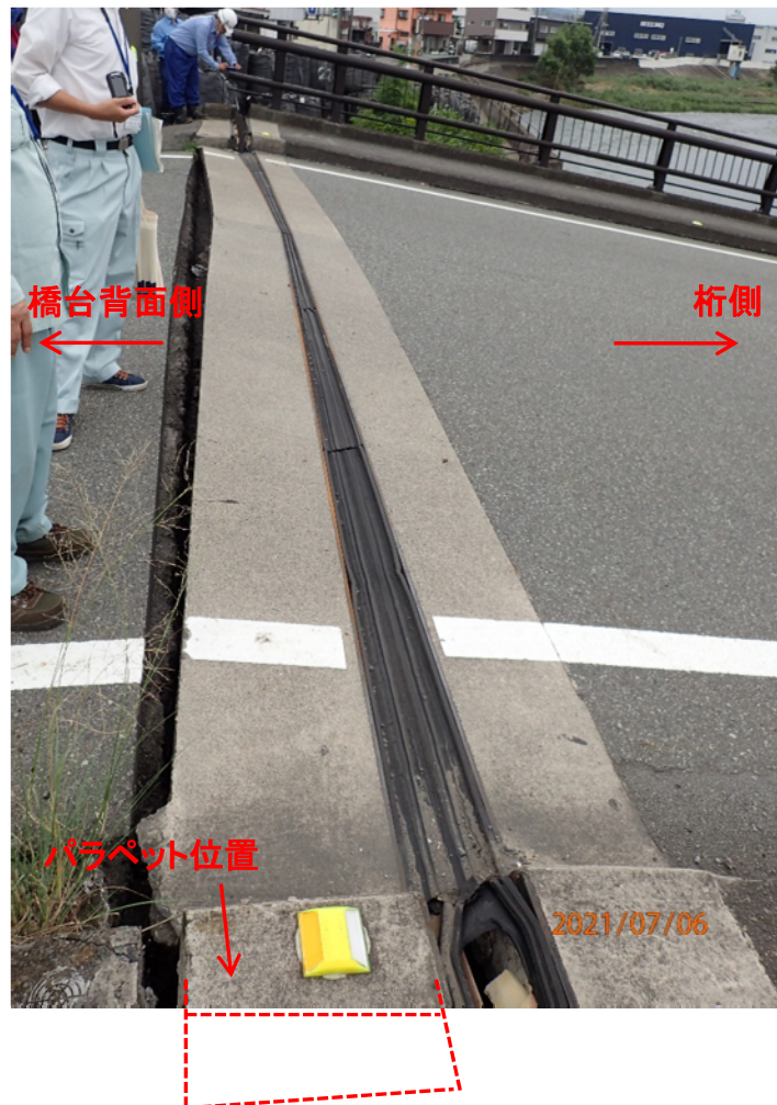
写真 5-9 A2 橋台上の桁端伸縮装置
