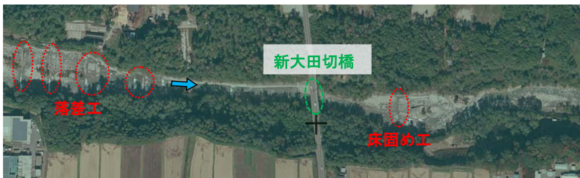
図5-21 被災前の新大田切橋周辺の航空写真（平成27年撮影） 10)
