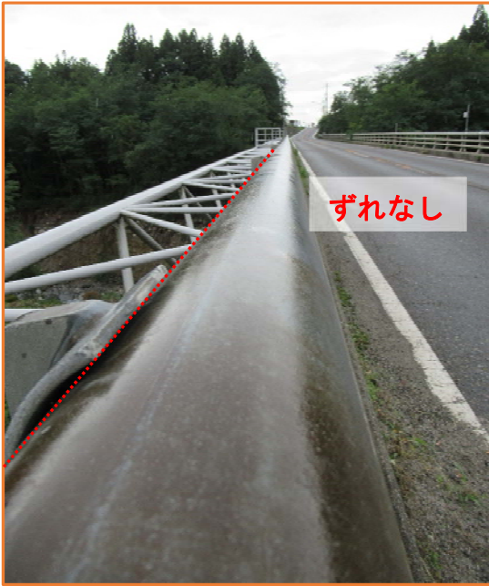
写真 5-15 被災後の橋梁上面の状況
