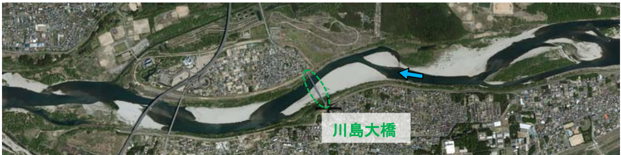
図5-17 被災前の川島大橋周辺の航空写真（平成20年撮影） 10)
