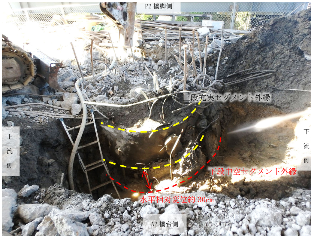
写真 2-⑦ P3 橋脚 掘り起こし状況
