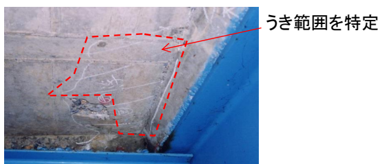
剥離箇所の周囲を打音検査した例
