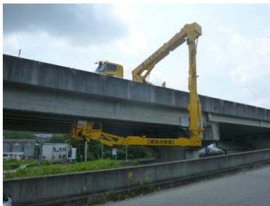
橋梁点検車による定期点検
