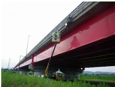
高所作業車による定期点検
