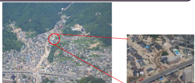
平成30年7月豪雨による土砂・洪水氾濫の発生状況(広島県呉市)
