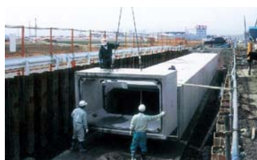
ボックスカルバートの施工例
