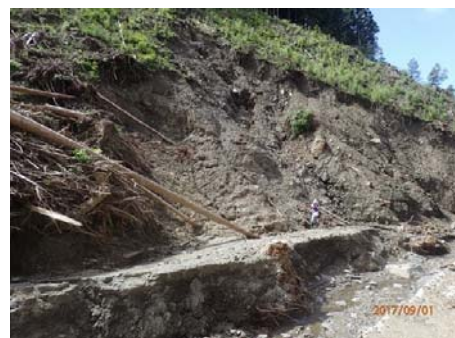
斜面下部浸水による急傾斜地崩壊
