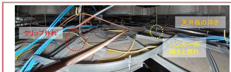
水平レーザーによる確認状況 ※天井面から水平レーザー照射面までは15mm
