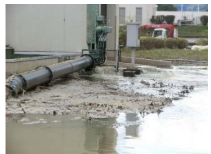
機能停止直後から、流入水がポンプ棟のマンホールから溢水
