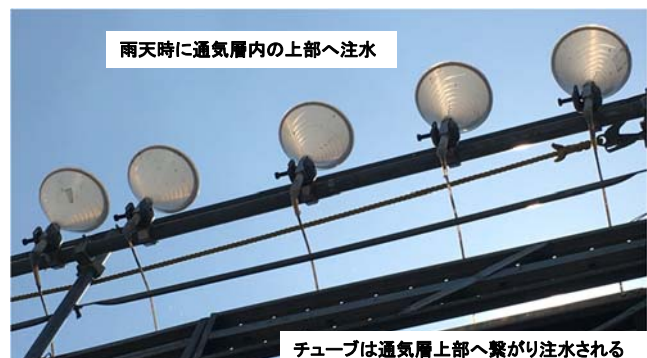
注水用漏斗とチューブの設置
