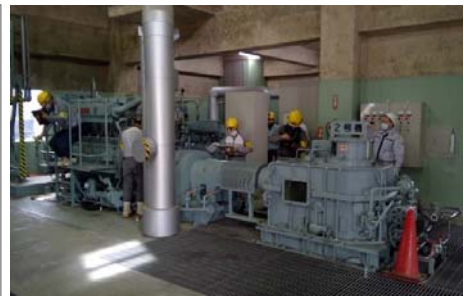
ポンプ設備の運転状態の点検状況
