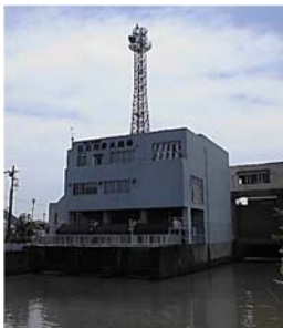
排水機場外観
