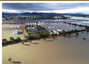
B川流域における浸水被害を受けた下水処理場
