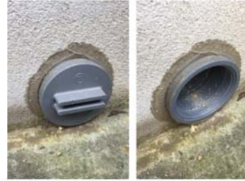
被災時に床下の排水が困難であったため、ベタ基礎の立上り下部に水抜き穴を設置(平常時はキャップ止め(左写真))。
