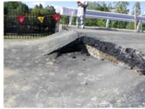
段差実験例 (舗装)
