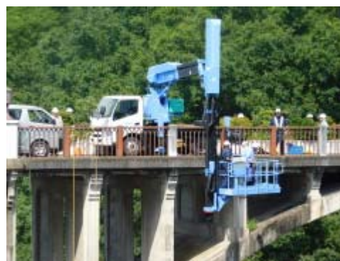
図 1-2 秩父橋の直轄診断 (R1.8)
