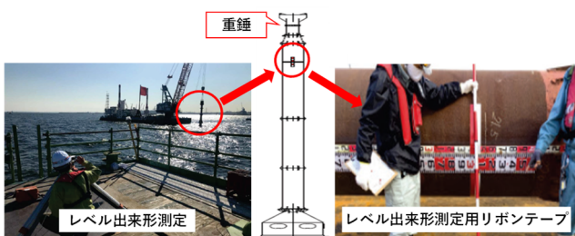
図-2.6 捨石高さレベル出来形測定
