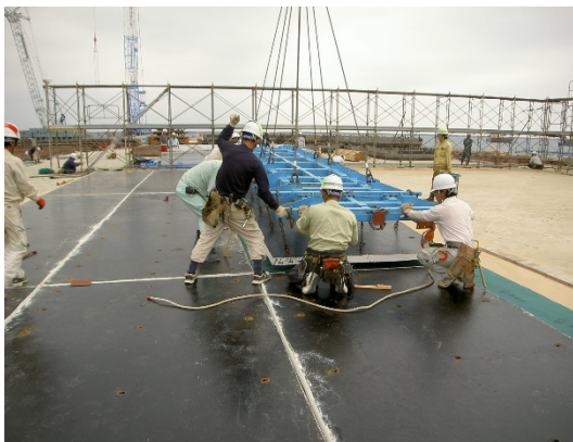
(a) ケーソン製作ヤード
