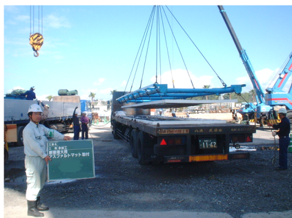
写真-A.2 アスファルトマット積み込み状況
