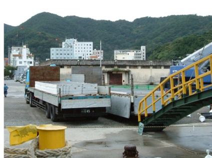
写真-A.3 アスファルトマット運搬状況
