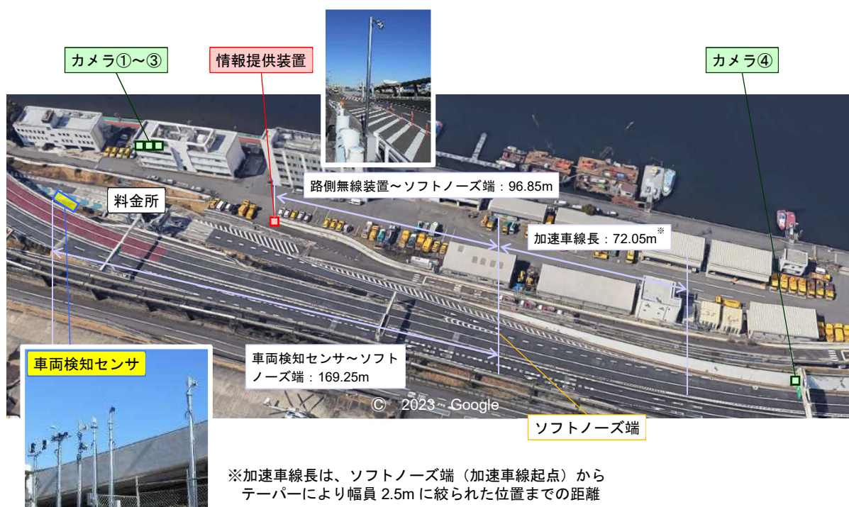
図 4-8 各機器の配置状況
