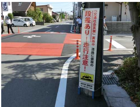
平坦部はアスファルト舗装 傾斜部は可搬型ゴム製ハンブ
