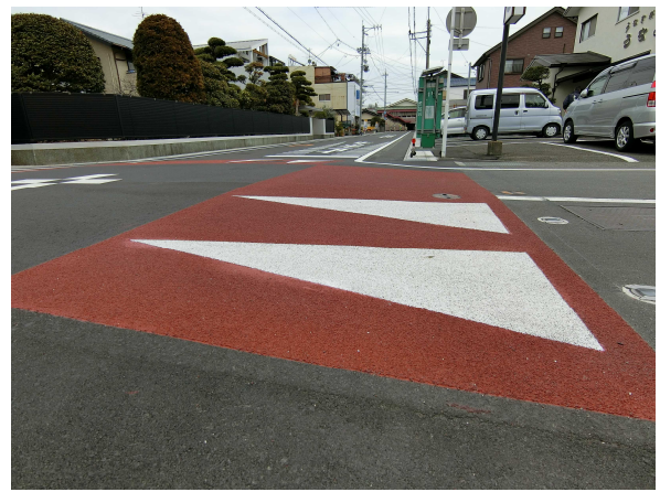
傾斜部はサイン曲線で施工
