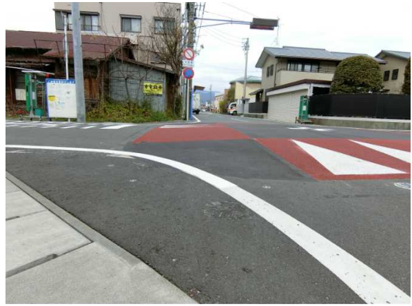
隅切り部に平坦な路面を確保
