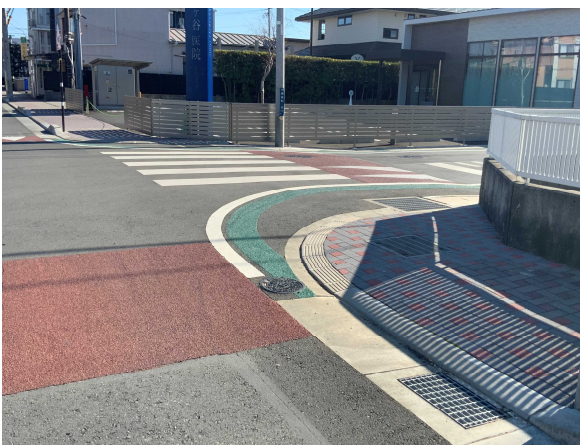
既設歩道と横断歩道のすりつけ (交差点部ハンプ②(スムーズ横断歩道))
