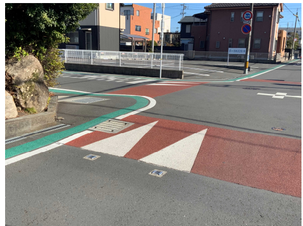
傾斜部での排水柵嵩上げ (交差点部ハンプ②(スムーズ横断歩道))
