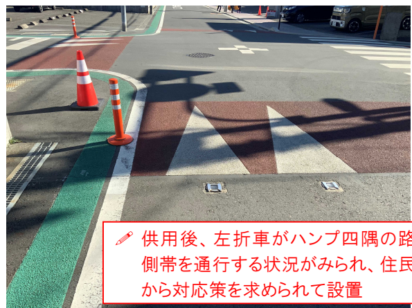
追加設置したゴム製ポール (交差点部ハンプ③(スムーズ横断歩道))
