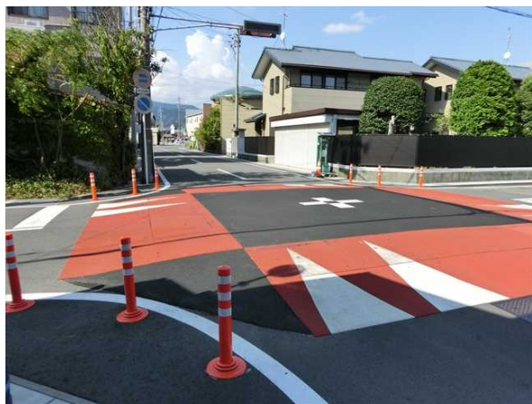
平坦部はアスファルト舗装 傾斜部は可搬型ゴム製ハンブ
