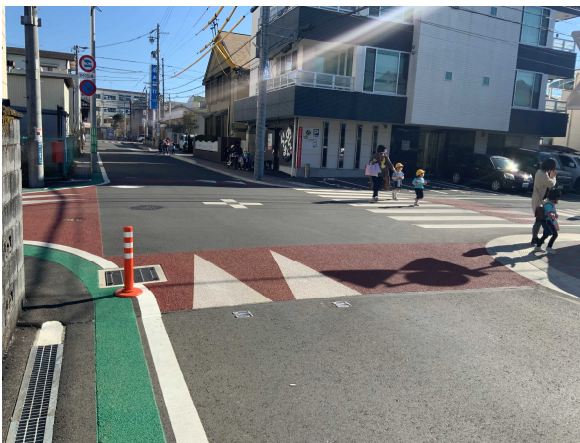
概観(交差点部ハンプ④(スムーズ横断歩道)) 歩行者通行状況
