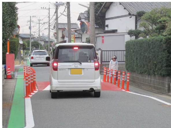
提供:福岡国道事務所
