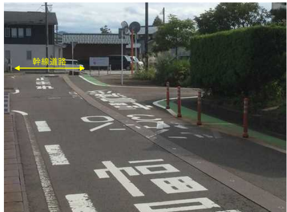
対策エリア入口部での狭さく設置
