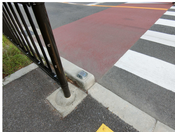
傾斜部の縁石と自発光鋏(第1工区)
