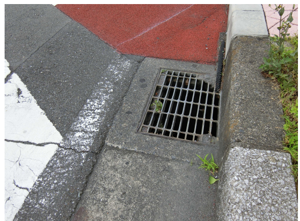
集水柵と排水ドレーン
