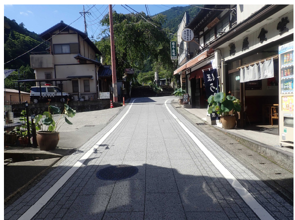
歩車一体舗装
