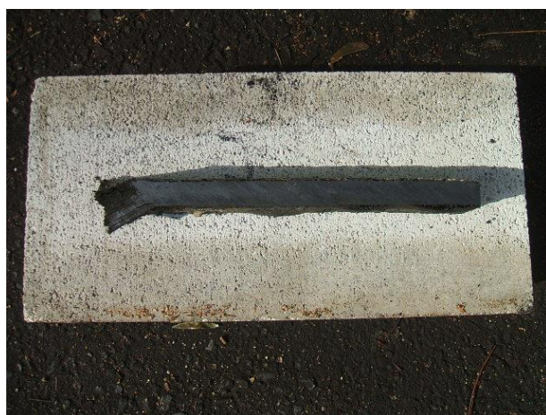
写真Ⅱ-2 硬質瀝青管の切り出し部分
