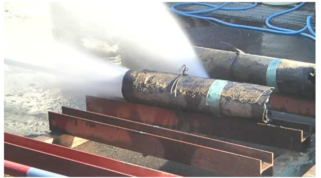
洗浄状況（側面の開いた穴より洗浄水噴出）
