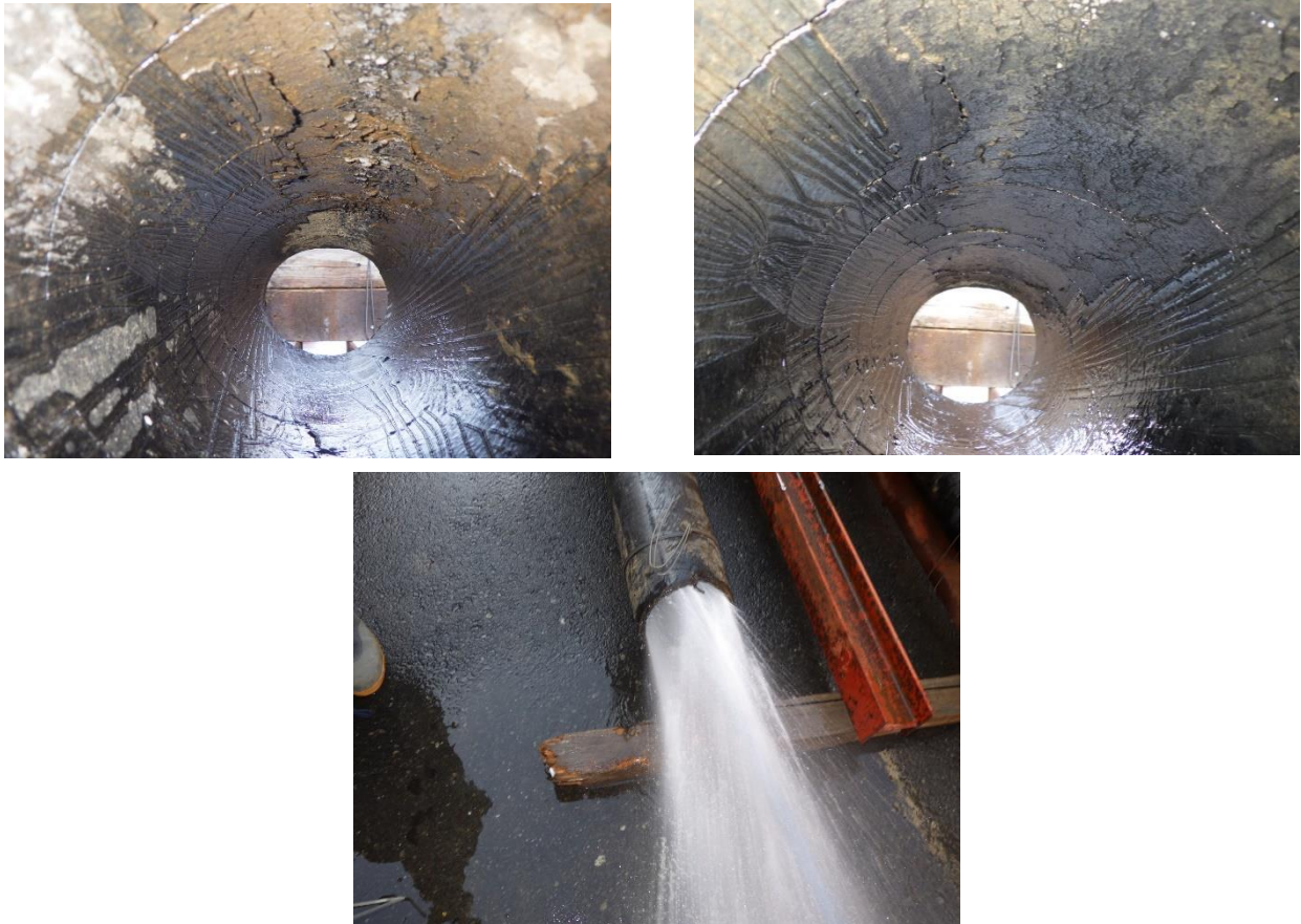
写真 3.3-3 波打ちの程度「なし」の高圧洗浄試験の状況 (後方噴射ノズル使用、洗浄時の圧力 10MPa) (左上：洗浄前、右上：洗浄後、下：洗浄状況)
