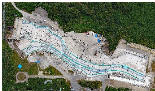
河川模型実験施設
