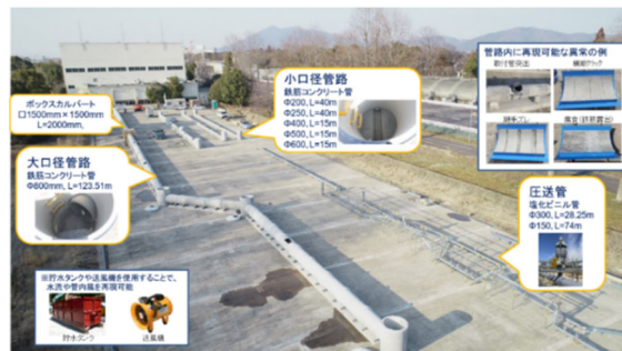
図 3-20-3 下水道管路模擬実験施設
