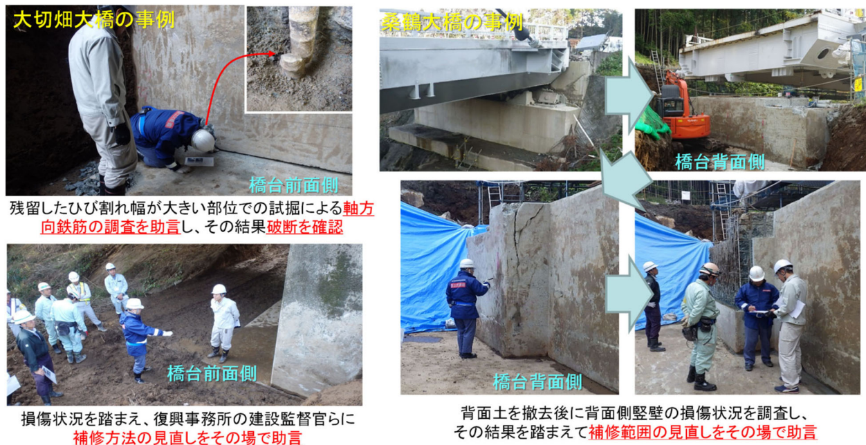
20 図 3-9-2 道路橋の復旧現場での復旧研の技術支援状況例
