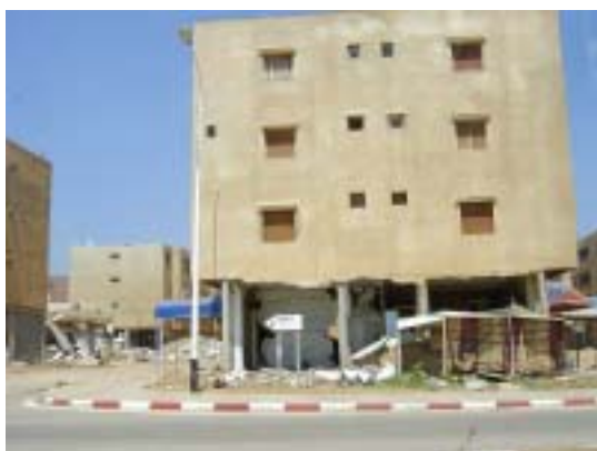
写真 1 1 階の煉瓦壁の崩落
