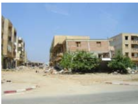
写真 3 完全に崩壊した建物
