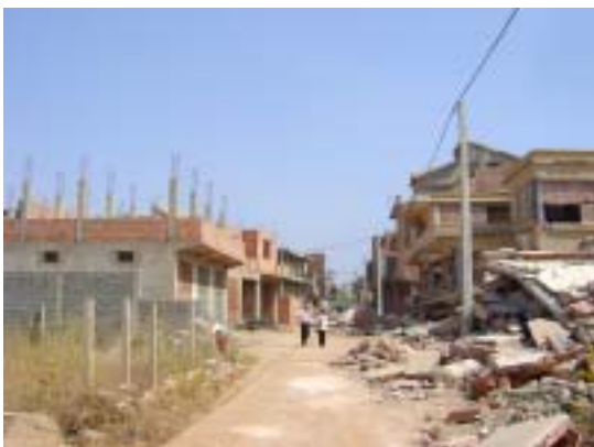
写真 1 3 比較的新しい住宅の被害
