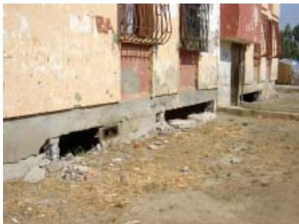
写真 19 半地下の設備階を有する建物
