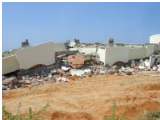
写真 4 完全に崩壊した建物
