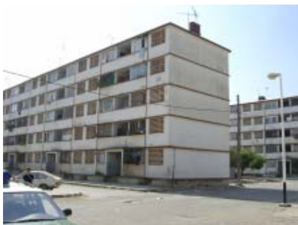
写真 21 壁式構造の建物 (無被害)
