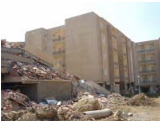
写真 1 5 崩壊した建物と残った建物
