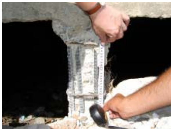
写真 20 短柱の被害
