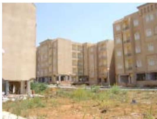
写真 1 4 比較的新しい公共住宅の被害
