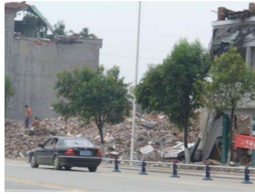
写真8 崩壊した建築物の残骸 めんちく かんおう (綿竹市漢旺鎮)
