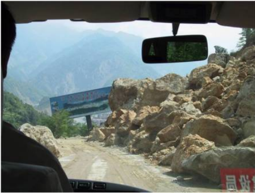
写真1 落石による道路損傷 (北川県入口)
