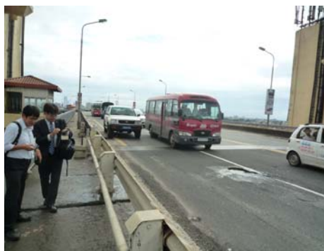
タンロン橋現地視察
