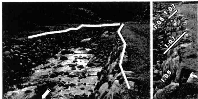
写真一八 山附川の護岸工法
