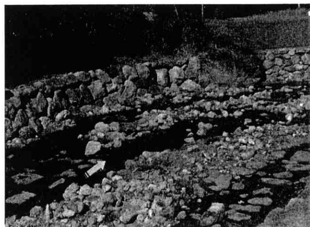
写真一九 護岸の一部として使用した転石
