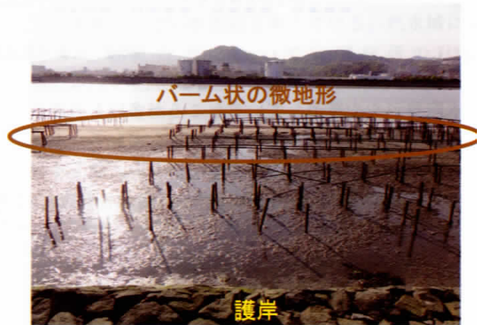
写真-1 放水路で見られるバーム状の地形
