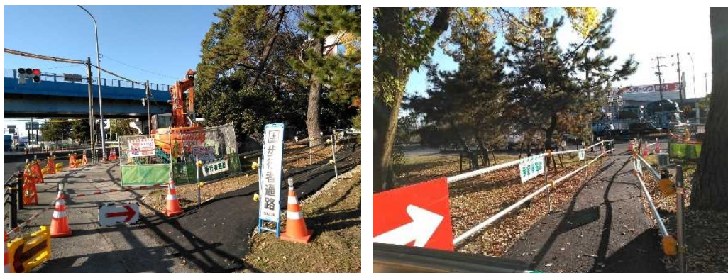
図 3.2.13 公園内に歩行者通路の設置した事例（国道1号岡崎朝日町電線共同溝工事）
