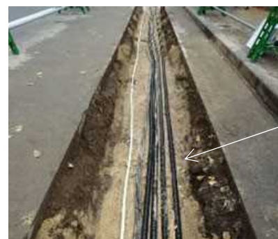
ケーブルを地中に直接埋設
