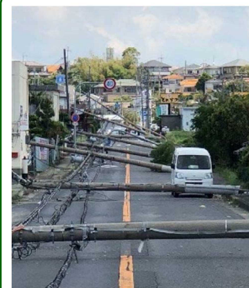
台風により倒壊した電柱
