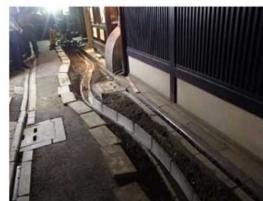
写真5-1 小型ボックス活用埋設方式の事例（先斗町通）
