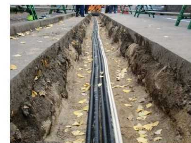
写真5-2 直接埋設方式の実験状況（東一条通）
