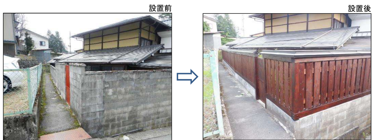
景観形成事業(塀等設置)補助金の活用により新設された塀
