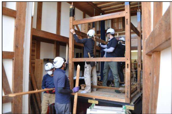
仙人台の解体
