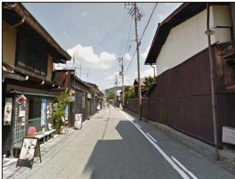
無電柱化予定路線(着工前)
