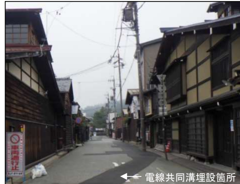
無電柱化工事写真(令和3年)
