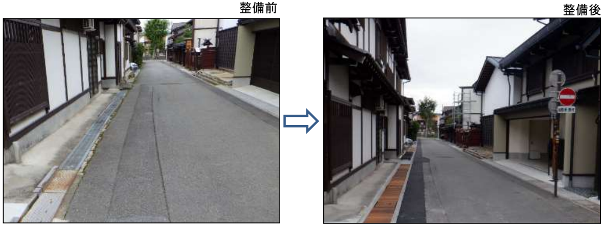
景観配慮型側溝整備の例(市道上二之町大新町線)
