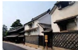
無電柱化による景観の向上
