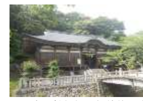
▲春日神社拝殿解体修理事業
