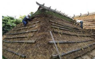
茅葺屋根の葺き替え
