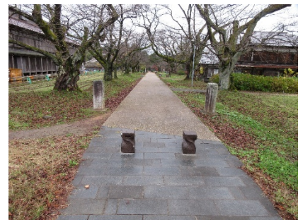
砂利風舗装と石貼り舗装の境
