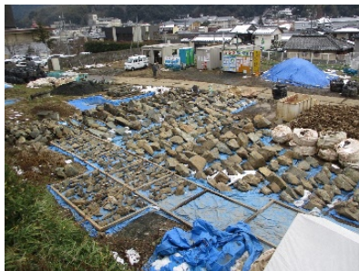
解体した石垣の石材
