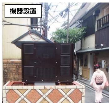
先斗町歌舞練場の看板を改修して、地上機器を収納したケース
