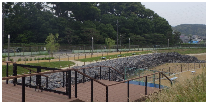
GRC パネルで再現された太閤堤の遺構
