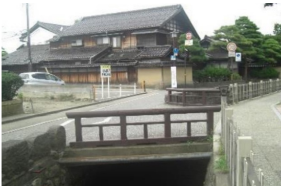
私有橋の撤去による用水の開渠化
