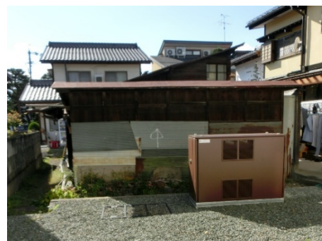
屋台蔵敷地への設置
