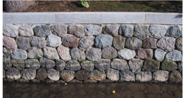
胴割石積みで整備された護岸
