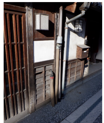
引込管路の立ち上げ状況
