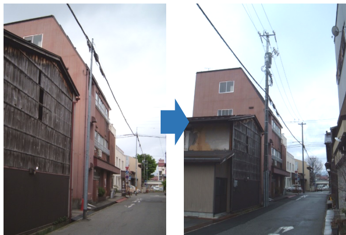
側道の電柱を NTT 柱から中部電力柱に建替えて電柱上に変圧器を設置（上記①に該当）
