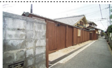
後退した位置に設置された板塀
