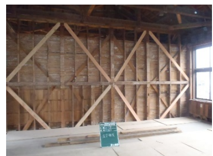
壁筋違いによる補強
