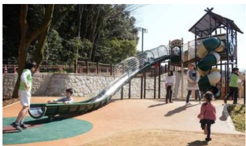
石積み擁壁による広場空間の確保
