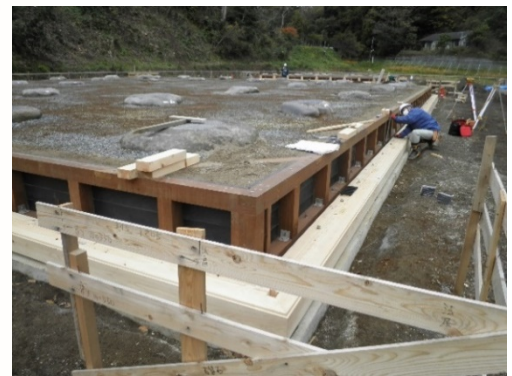
二階堂の基壇施工状況
