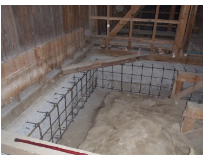
鉄筋による基礎の補強
