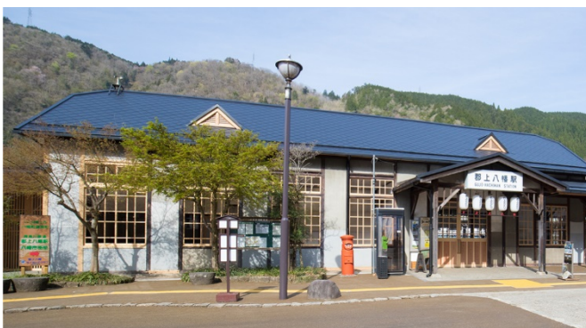
木製建具の窓やドーマー窓の復元
