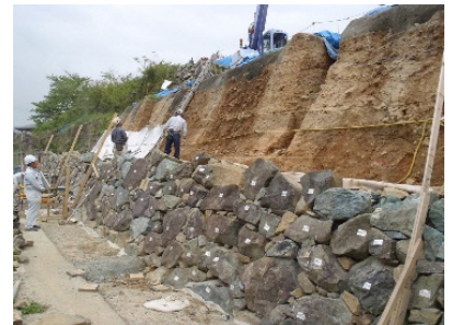
石垣の積み直し（石垣 A-1 箇所）
