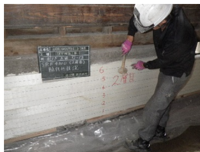
SRF 包帯工法による基礎の補強
