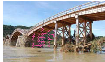
平成17年9月の台風で橋脚2基が流されるも落橋せず。橋脚は回収・再利用された。
