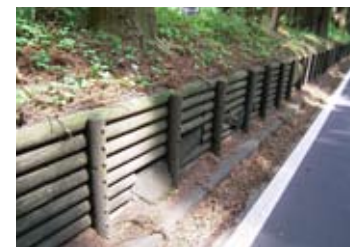
改良土壌を客土した木製土留め壁（日光例幣使街道）
