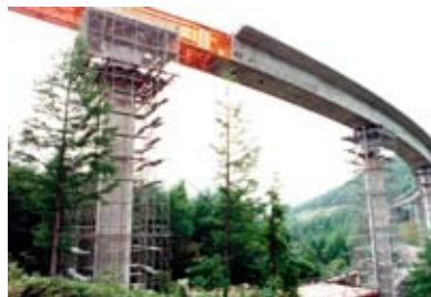
押し出し工法による施工中の様子
