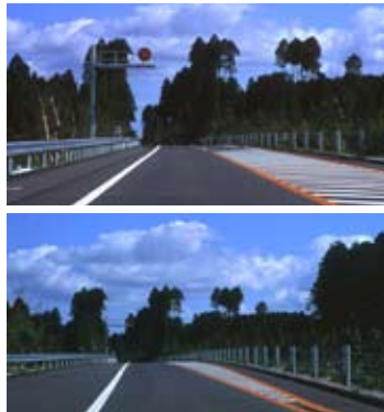
山武杉すり付け区間 上：暫定上り線側2車線供用区間 下：暫定形供用区間から完成形への移行区間 右：完成形整備区間
