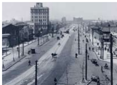
拡張工事後の様子
