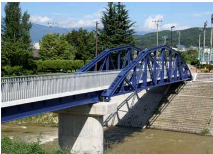
【りんどう橋】(橋長51.35m(トラス部支間32.35m) 長野県上田市 2007)
