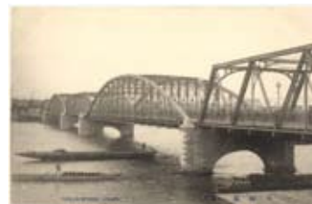
スパン 66 m のボーストリングトラスを主径間に用いた明治 21 年竣工の天神橋
