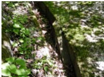
這出しスロープの設置
