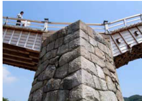
アーチを受けとめるシャープな橋脚形状
