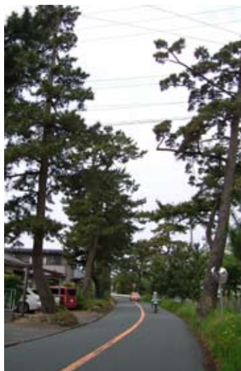
保全事例1 袋井 道路がかさ上げされ、かつての土塁の上端が路面となっている。松並木は古木86本、補植128本。
