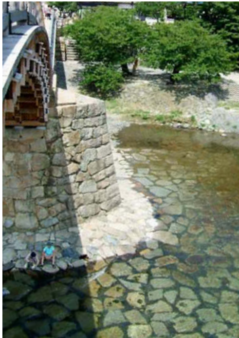
石積橋脚と河床の敷石が美しい
