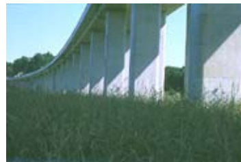
近視点での橋の見え方、桁のおさまり
