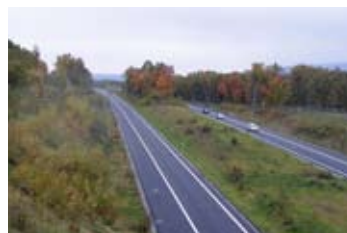
盛土築堤 防護柵を排除している。
