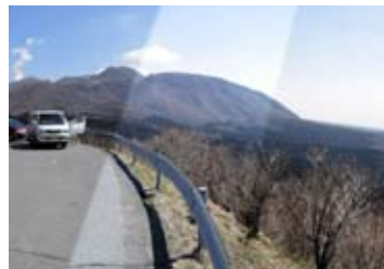
瀬の本（亜鉛メッキのガードレール）
