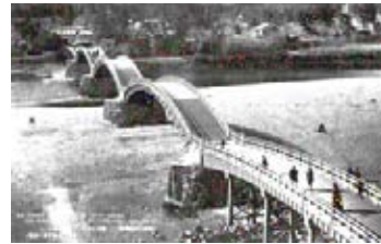
空石積橋脚の頃の錦帯橋（橋脚で80cm、橋台で50cm、現在のものよりも低い）
