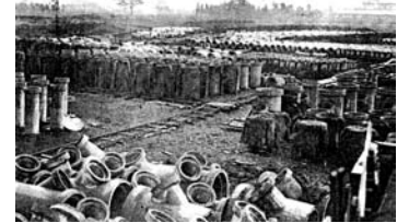
鉄筋コンクリート管製作工事
