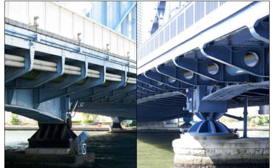
船運が盛んだった昭和初期に造られた隅田川橋梁群は、ブラケットなどの桁側面の表情を始めとして、桁裏や支承、橋脚などのディテールが、見られることを意識したデザインとなっている。平成に入って整備されたライトアップ用の配管や灯具が、昼の景観を妨げているのが残念である（左：永代橋、右：清洲橋）
