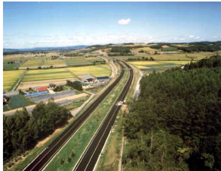
暫定施工区間の外側2車線運用
