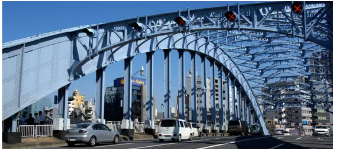
雄大なアーチリブと繊細な上横支材の組み合わせが美しい。接合部のディテールに着目
