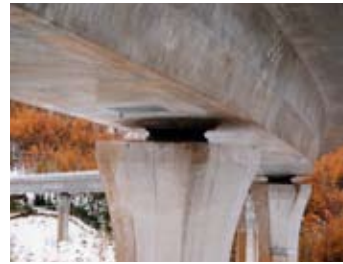
支承部温度変化による桁の伸張収縮は、曲線桁の平面的な変形でとらせている。橋脚上ではゴム支承がその変形を逃がすため、せん断変形が生じている。この写真は冬季のもので、桁は収縮するため、曲線の内側に変形していることが見てとれる。
