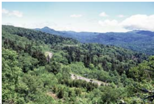
旧道から見た 定山溪国道
