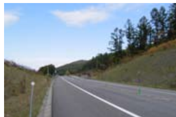
暫定2車線 切土のり勾配は、完成時の用地の範囲幅で、切盛バランスを改善する限り、自在に変化させている。
