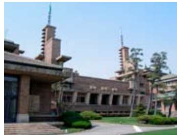
武庫大橋右岸上流側すぐに位置する旧甲子園ホテル（現在：武庫川学院甲子園会館）の現在の様子
