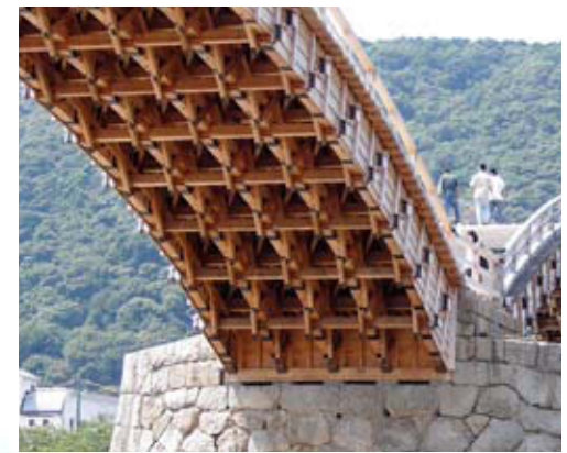
鞍木や肋木による繊細な木組みと、安定感のある石積橋脚の組み合わせが、自然景観に調和する
