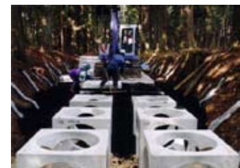
中空ブロックの施工状況（日光御成街道）
