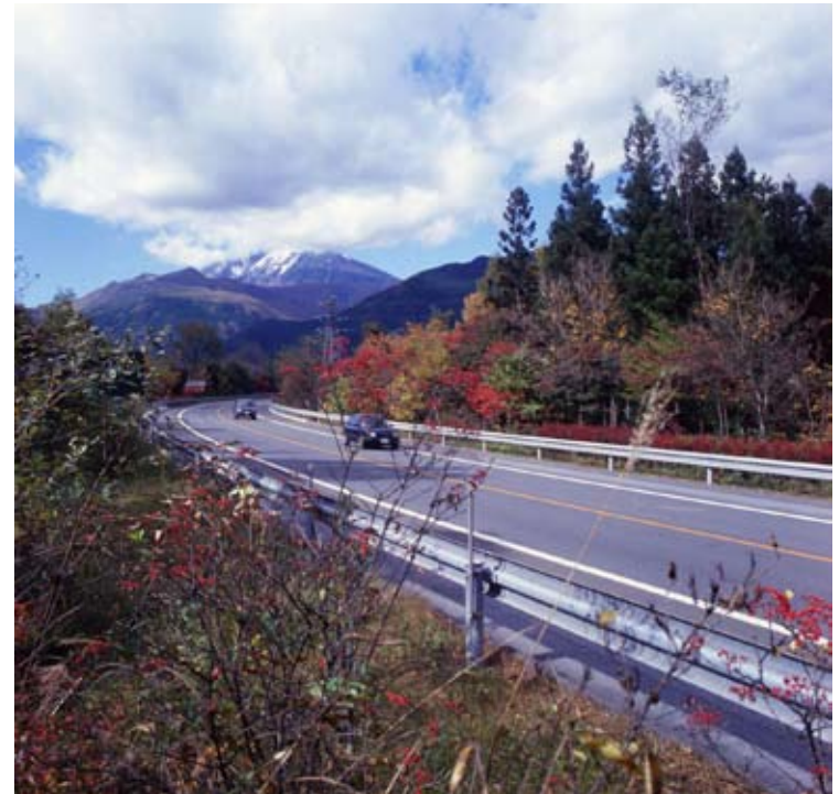
地域景観に調和し季節感のある走行景観が得られている盛土法面の植栽
