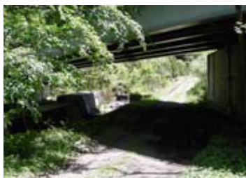
橋台のセットバックによるけもの道の保全
