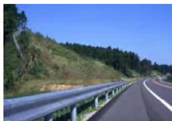
前付け植栽による伐開断面の保護
