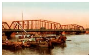
明治30年造のトラス構造の永代橋
