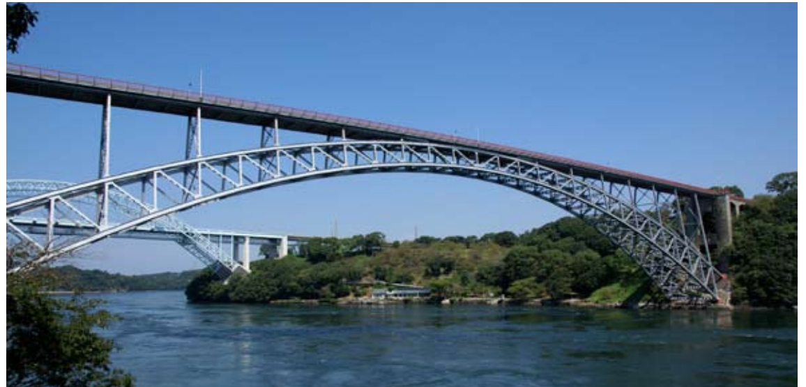
背景を透かすブレースドリブアーチが、雄大で大らかな自然景観に融和する。部材バランス、アーチ形状、支承部等のディテールなど、すべての面から設計者の意思が読みとれる。後世にメッセージを残す橋である
