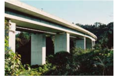
アプローチ橋の全景
