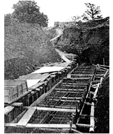
ボックスカルバート築造工事
