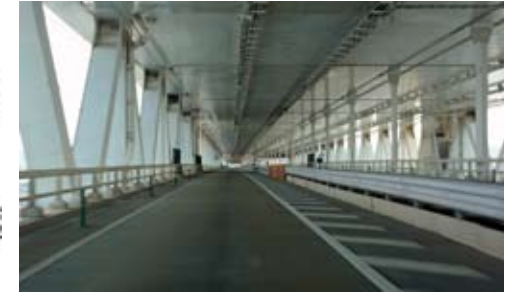
下層道路内空間(2007年現在、片側車線のみ運用)
