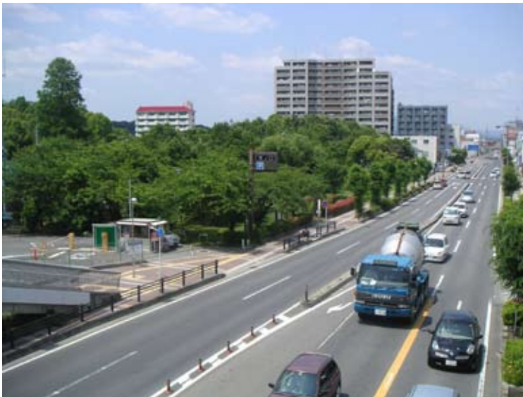
国道153号から見た児ノ口公園 交通量の多い国道沿いに豊かな緑を提供している。
