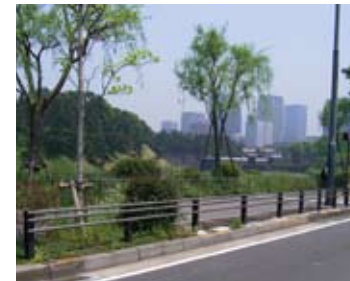
歩車道境界部防護柵
