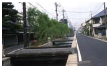
河川と道路の間の防護柵の排除（同上）
