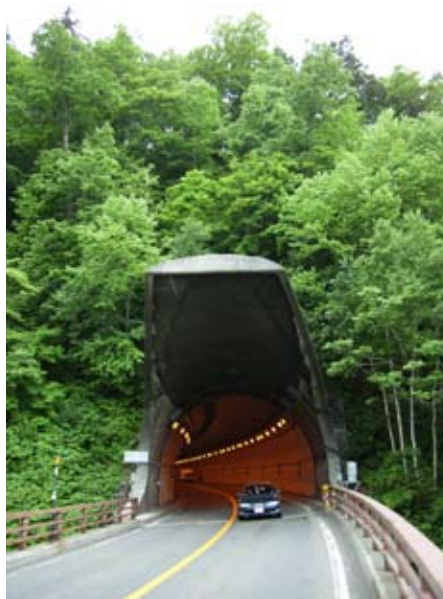
雪崩を切り裂く形状の薄別トンネル坑口
