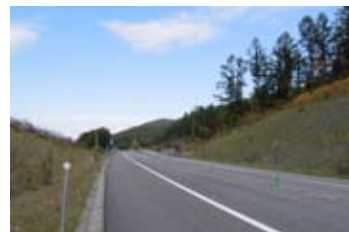
暫定2車線 切土の勾配は、完成時の用地の範囲幅で、切盛バランスを改善する限り、自在に変化させている。
