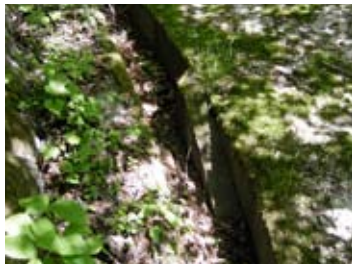
這出しスロープの設置
