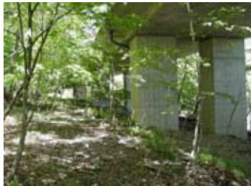
フェンスの撤去による生息環境の保全
