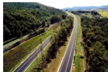
上下線分離 切盛土量の削減と中央分離帯の既存林保存を実現。
