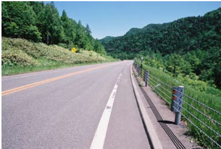
グレーディングにより周辺植生の侵入が進んだ法面（左）
