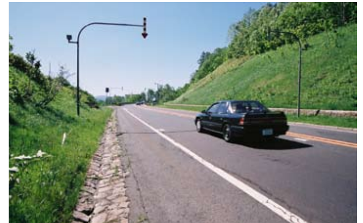
現地発生材を利用した皿型側溝と擁壁
