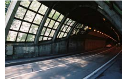
入口から内部へ徐々に採光面積が少なくなる坑口により運転者の明暗順応を図っている。
