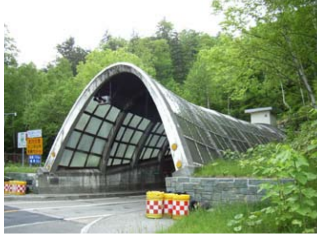
トンネル進入時の抵抗感が少なくなるよう配慮されたトンネル開口部
