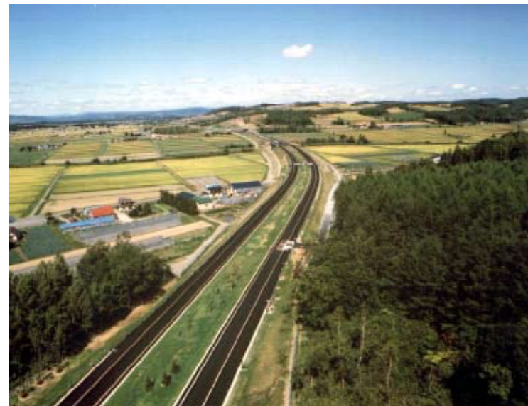
暫定施工区間の外側2車線運用
