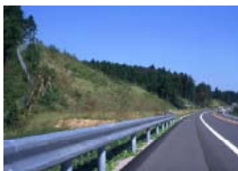
前付け植栽による伐開断面の保護
