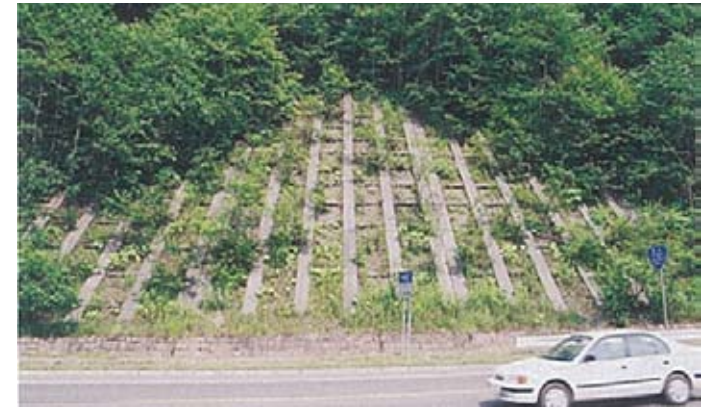
横フレームの印象を弱くすることにより法枠の存在印象を弱めている
