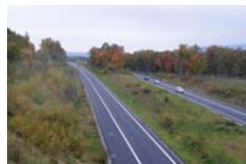
盛土築堤 防護柵を排除している。
