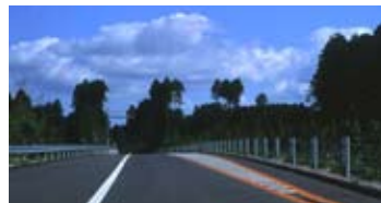
山武杉すり付け区間
