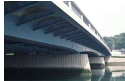
すっきりとした桁下と安定感のある橋脚
