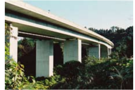
アプローチ橋の全景
