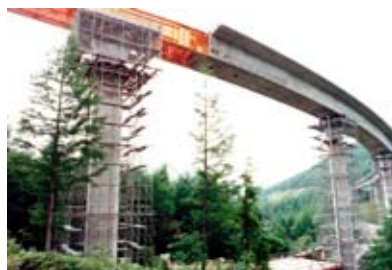
押し出し工法による施工中の様子
