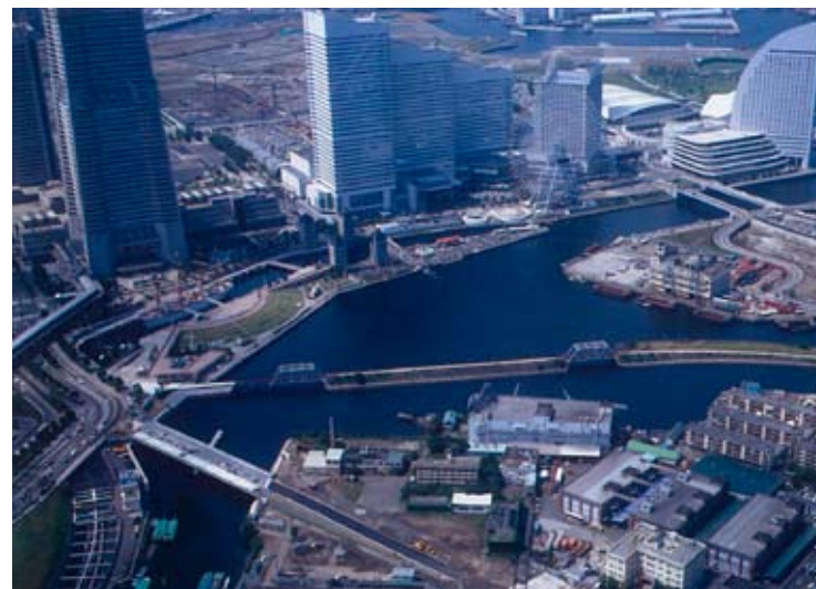
【自動車道における鉄道廃線跡の再生】(横浜市 1998)
