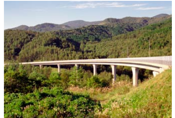
林立する橋脚が周囲の樹林と同化し、地山を痛めた印象が少ない
