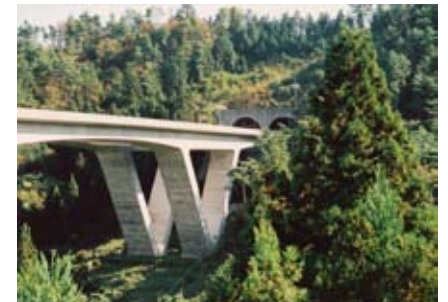
トンネル坑口と橋台部の好ましい取り合いの姿
