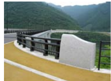
親柱と橋詰空間
