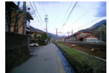
JR沿いの建物裏に移設電柱
