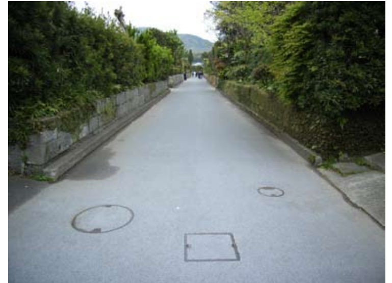
グレー系脱色アスファルト舗装 桝蓋等は道路上に出現するものを極力少なくするとともに舗装との一体感を持たせている。
