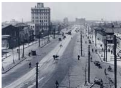
拡張工事後の様子
