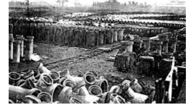
鉄筋コンクリート管製作工事
