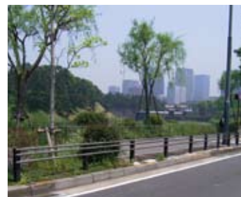
歩車道境界部防護柵
