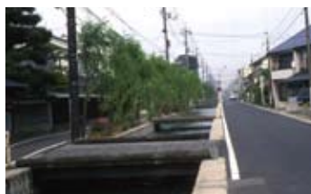
河川と道路の間の防護柵の排除（同上）
