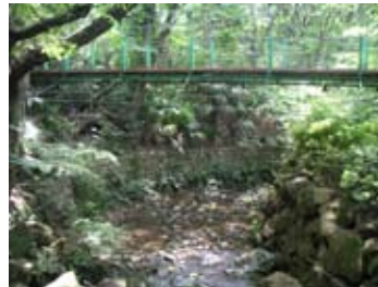
公園を縦断する谷戸川とそれを渡る吊橋
