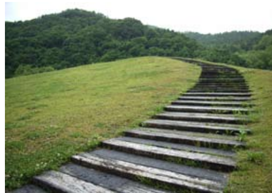
鉄道の枕木の再利用した頂上へ向かう階段
