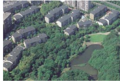
港北ニュータウン 鴨池公園付近（Ⅱ地区Dゾーン）
