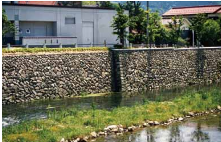
護岸の深目地仕上げ(出典9-11)
