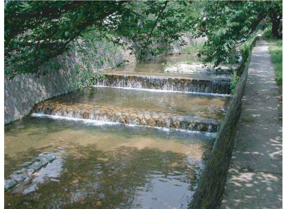
■各所に設けられている堰堤(床止工)(出典4-14)
