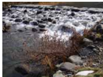
帯工の状況(近景)(出典8-7)
