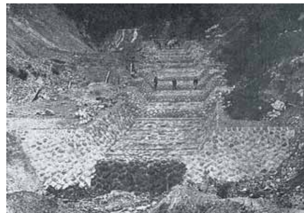
■工事中のフランス式階段工 (出典19-7) 写真上部に見える水の流れが、第1堰堤。
