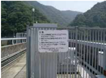
天端高欄より低く抑えられた巻き上げ機 (出典24-7)
