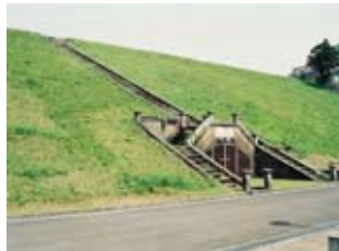
93 本川内高部ダム
