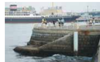
■バルコニー一部の石積みと外付き階段（出典4-9）
