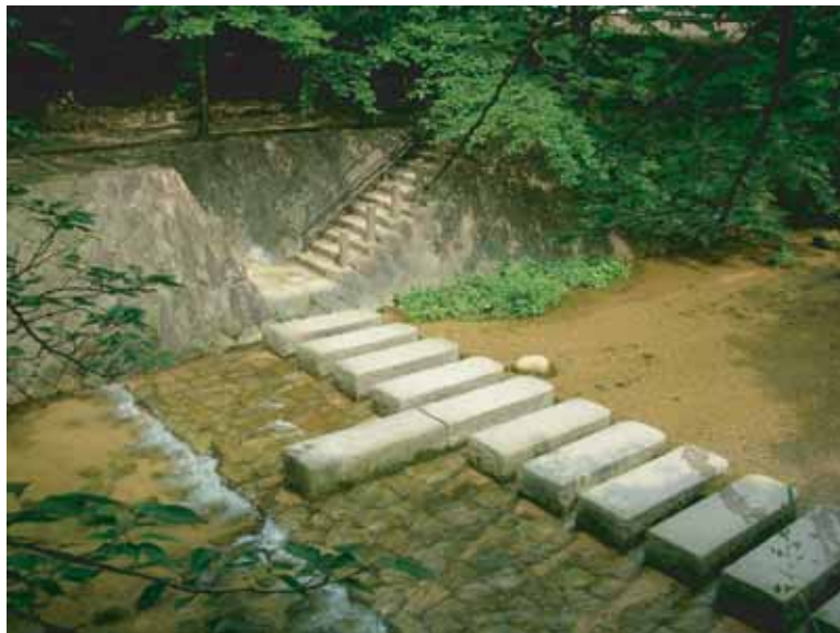
■堰堤(床止工)周辺に設置されている飛び石(出典4-13)
