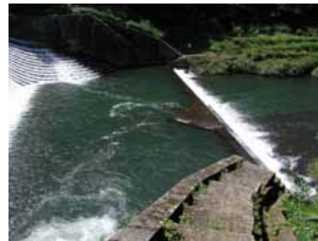
右岸階段部のデザイン(詳細)(出典25-17) 側壁が一定の高さを保っている区間では、階段面が側壁から突出しないようになっているのに対し(上左)、側壁自体が段状に低くなる下流側区間では、階段面が段状の側壁と一致している(上右)。
