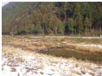
帯工の状況(遠景)(出典8-6)
