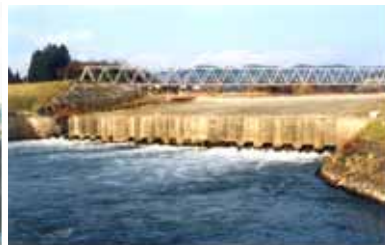
鴉波洗堰(旧施設)(出典15-5)
