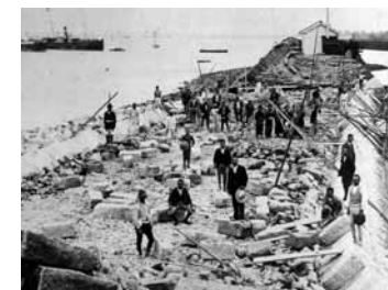
■一丁台場の築造あるいは改修時の写真 (出典6-11)
