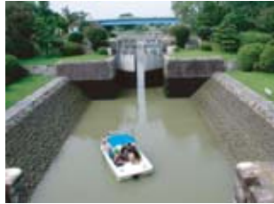
54 木曾川・船頭平閘門
