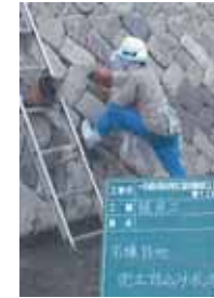
■半練護岸の工事(出典6-9)
