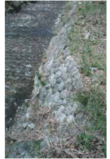
■護岸部は、8分の法勾配となっている。なお、天端は切天端である。(出典19-15)
