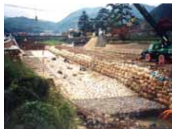
落差工の施工状況(出典9-14)
