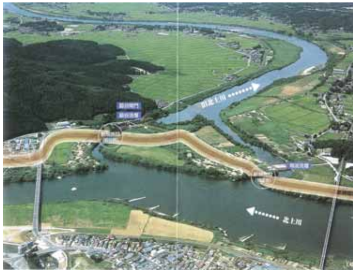
旧北上川分流部の全景(出典15-1)
