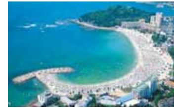
■ヘッドランド工法及び潜堤により安定海浜を造成した例（白良浜）（出典5-5）
