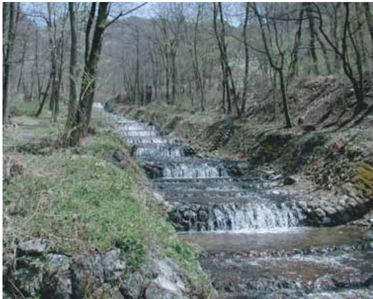
■階段工の全景(出典19-1)
