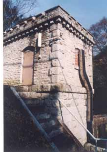
分水堰堤覆屋(出典23-13) 少流量の清流とそれ以上の濁流を分水するために築造された施設。弧形状の堰堤と取水機器が入る覆屋が設けられている。
