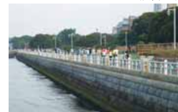
■山下公園の石積み護岸（出典4-10）
