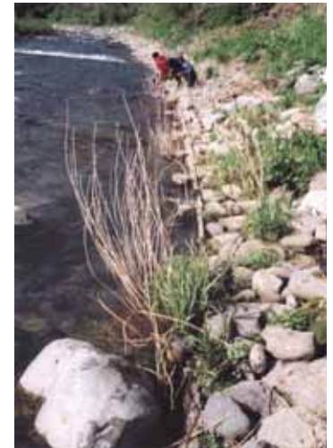
水際部の空石積み工と柳枝工(出典8-8) 整備直後の状況
