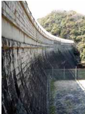
堤体横方向からの眺め(出典23-9) 緩やかなアーチ形状とコーニスの水平ラインが強調される
