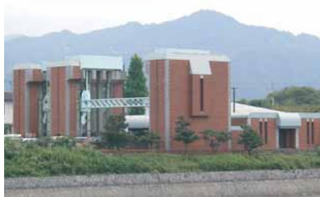
■瀬田川洗堰・バイパスゲート (昭和62年、写真:出典26-23、図:出典26-24) スライド3段シェル構造ローラーゲートを採用し、細かな水量調整を可能にするとともに、全開時の扉高をおさえている。
