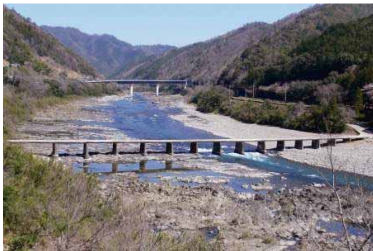
四万十川の半家沈下橋（潜橋）（出典28-15） 後ろに架かる通常の橋梁と比べるとその特徴の差が明瞭である
