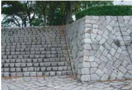
■広島県・太田川(出典27-7) 階段との取り付け、隅角の処理が丁寧。
