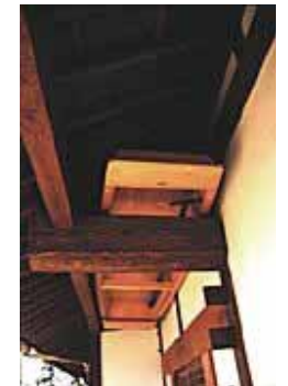
水屋に見られる洪水対応の知恵(出典28-14) 盛土された敷地の上に立つ母屋から、さらに一段高い塚の上に立つ蔵に避難するための階段が設けられている。水屋には避難用の船を準備している場合も多い。
