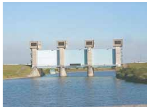
■昭和58年に新たに完成した新岩淵水門 (出典14-14)
