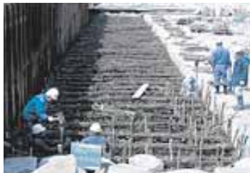
■堰下流に設けられた粗朶沈床(出典16-16)
