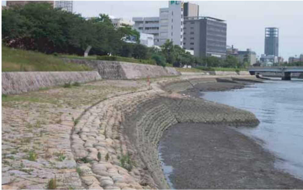
■基町護岸(水制、空鞆橋下流部、出典7-1)
