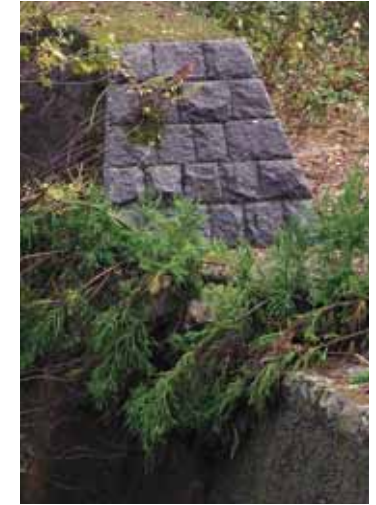
上三岳川砂防堰堤(出典21-13) 水通し天端に長方形に整形された石を布張状に配置し、袖小口も袖天端まで布積状に石積している。袖の断面形状が上流側も斜めになっているのは珍しい。コンクリート量の節約のためと考えられる。昭和初期の砂防堰堤で全体が打ちっ放しコンクリートのさきがけと考えられる。
