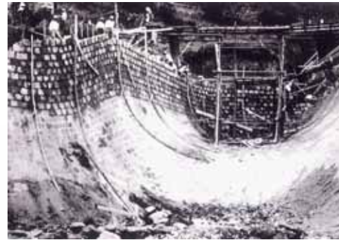
右岸側壁部の施工状況(出典25-10)
