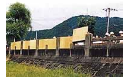
水防訓練の様子(出典28-4) 揖保川(龍野市)の水防訓練で畳を差し込んだ状況 ちなみに、揖保川では、幸いにも置堤を実際に活用する洪水は起きてはいない
