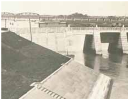
■建設当時の写真(下流より、出典14-7)
