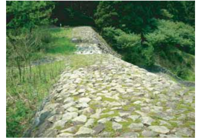
■袖の天端は水通しに向かって緩やかな勾配がある。(出典20-6)
