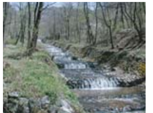
70 牛伏川・フランス式階段工
