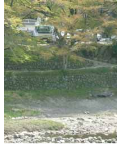
■分割された護岸の中に植栽された楓(出典2-2) 分割された護岸の間に楓が植栽されているため、背後の駐車場に停車している車が直接見えない。
