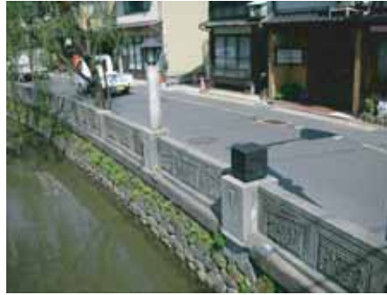
■特殊堤の上部に設置された街灯と橋梁ライトアップ用の照明(出典3-16)
