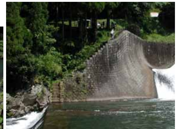
右岸階段部のデザイン(詳細)(出典25-17) 側壁が一定の高さを保っている区間では、階段面が側壁から突出しないようになっているのに対し(上左)、側壁自体が段状に低くなる下流側区間では、階段面が段状の側壁と一致している(上右)。
