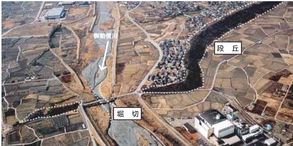
■堀切(D地点、出典1-10) 段丘の一部を掘削して、御勅使川と釜無川の合流部が高岩周辺になるように河道の安定を図った。
