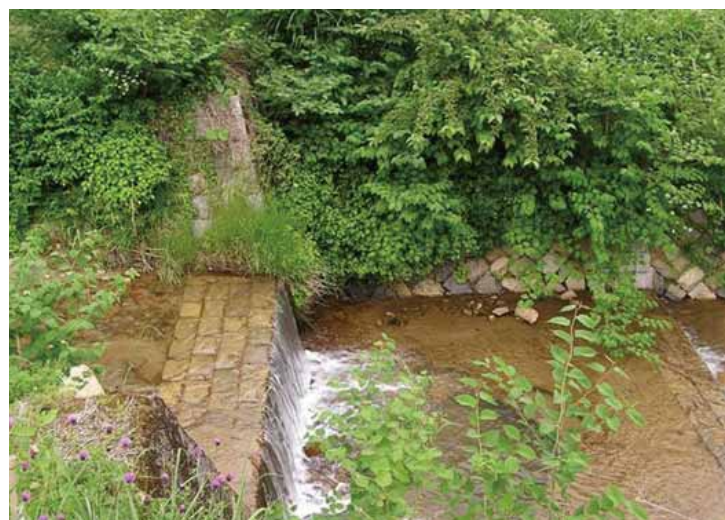
雲原川布張タイプ(出典21-15) このタイプは本副とも水通し天端には加工した石を横長に布張りにしている。しかも施工が丁寧で石の色と形がそろっているためとても美しい仕上がりとなっており、本流路の中で最も優れている。いわば雲原川流路工デザインの集大成である。
