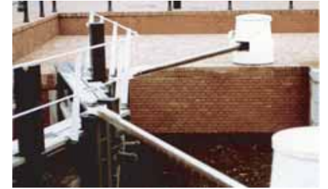
■一般的な合掌戸の開閉に用いられる直線駆動ギア(出典13-7)
