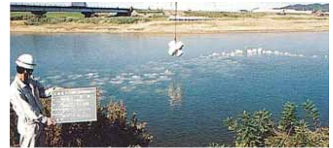
根固めブロックの施工状況（出典11-11）
