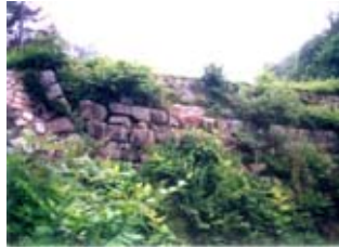
76 堂々川砂防砂留工群
