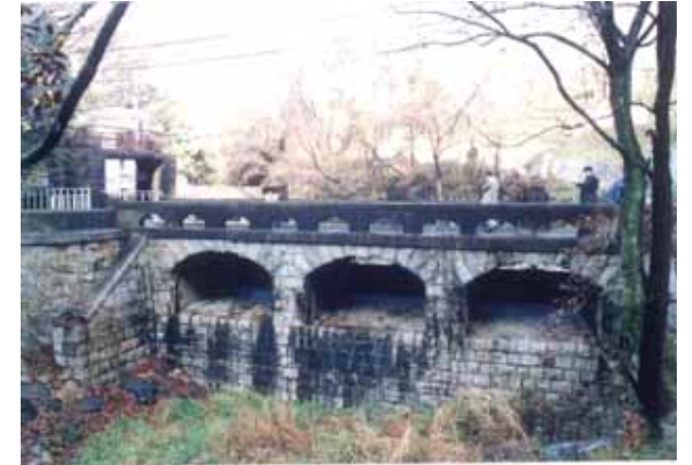
縮切堰堤（断流堤）(出典23-14) 放水路の水量を調節するための施設。3個の溢流口を持つ。
