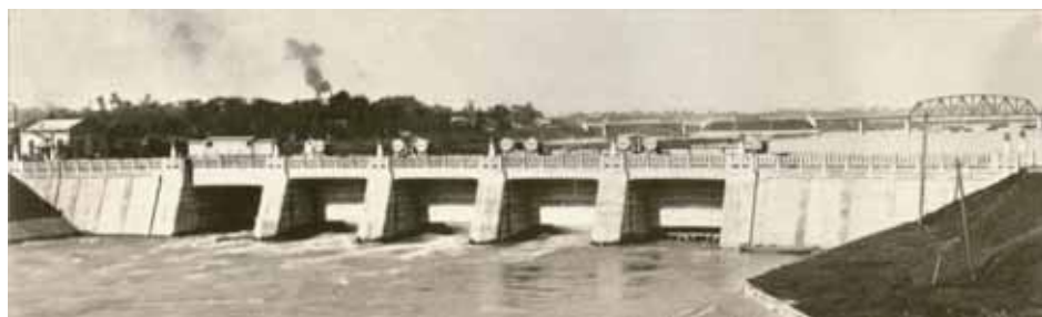
■昭和3年当時の水門全景(下流左岸側より、出典14-2)
