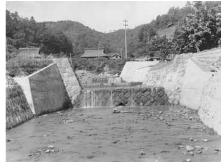
床固工竣工時写真（三岳川：昭和10年頃）（出典21-6）
