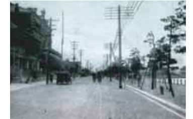
■山下公園整備前の海岸通り（出典4-3）
