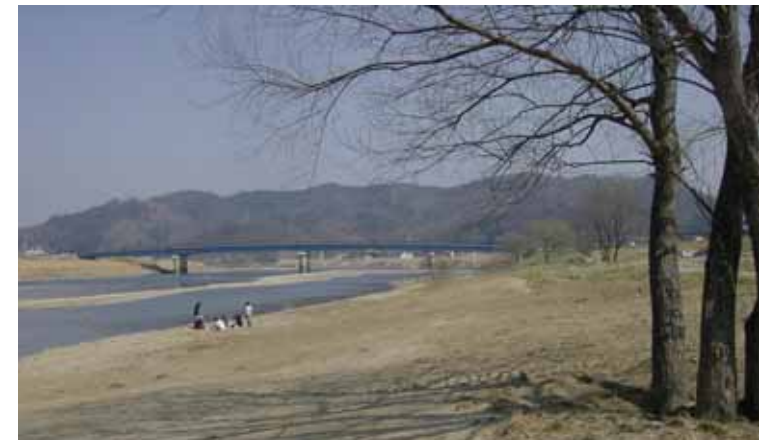
見直しによる再整備(出典10-24) 堆砂部分をスライスし、敷き均しを実施(平成16年3月)
