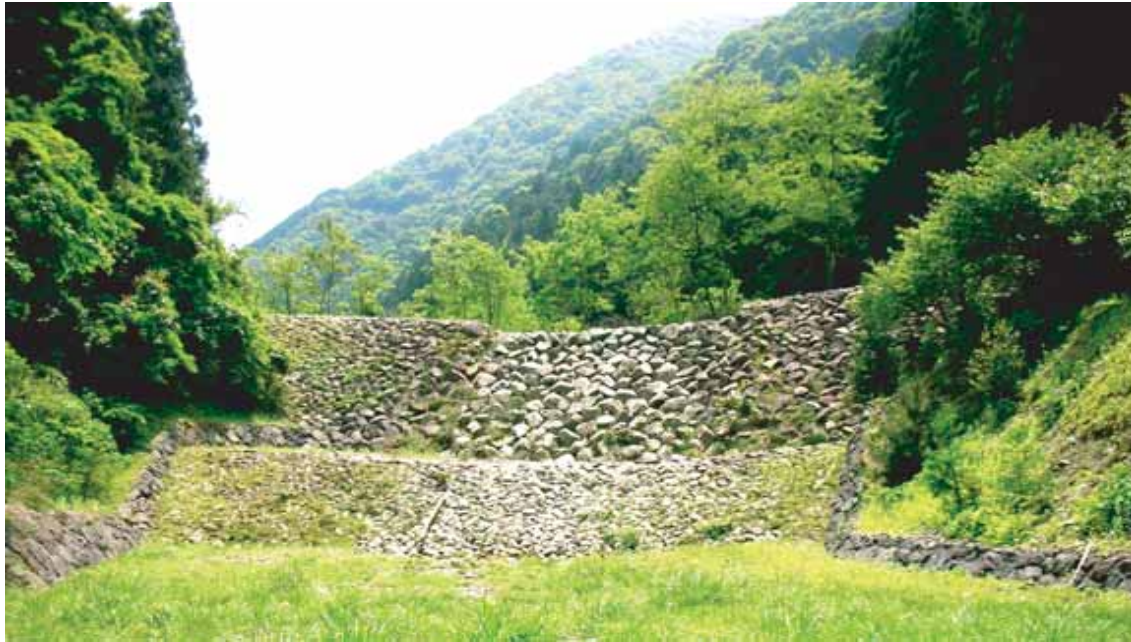
■羽根谷砂防堰堤(第一堰堤)の全景(出典20-1)
