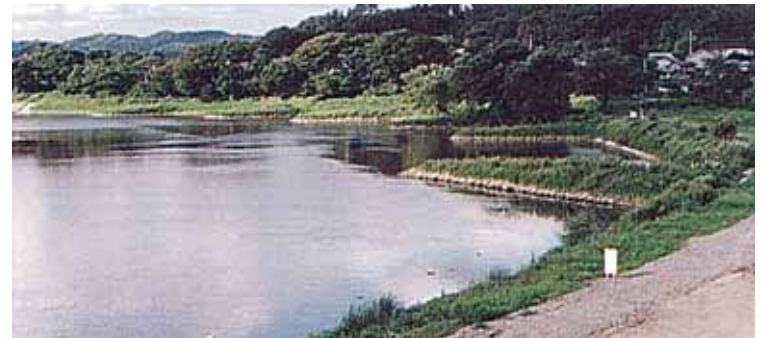
施工後1年6ヶ月経過(1996年9月)(出典11-8)
