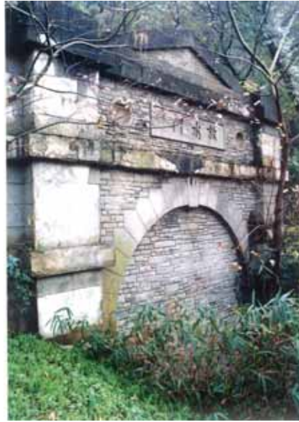
放水路槽台(出典23-12) 本流の吸口に設けられた放水門の操作用の槽台。この下に（写真では写っていない）ストニー式扉門がある
