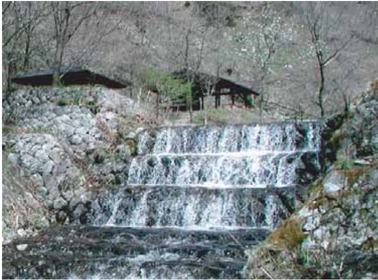
■上流端の内務省第1号石堰堤すり付け部は3段の落差で処理されている。(出典19-13)
