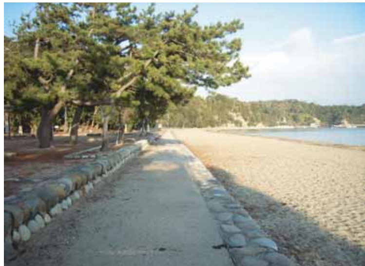
■護岸部分(出典3-9) パラペット背後に設置した植栽樹の一列松により背後の公園と連続
