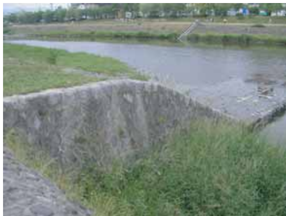
■床止堰堤の袖壁部(出典5-16)
