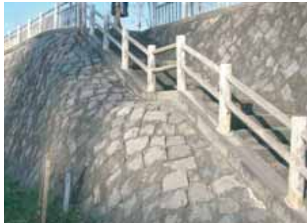
■秋田県・横手川(出典27-8) 階段との取り付けを巻天端として処理。
