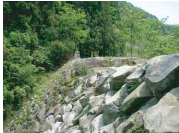
■本体よりも50cm程度内側に引き込んだ落水部分。(出典20-7)
