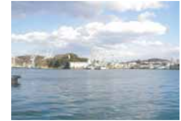
■造船所の眺め（出典8-23） 造船所のクレーン等も水域を挟めば視対象となる
