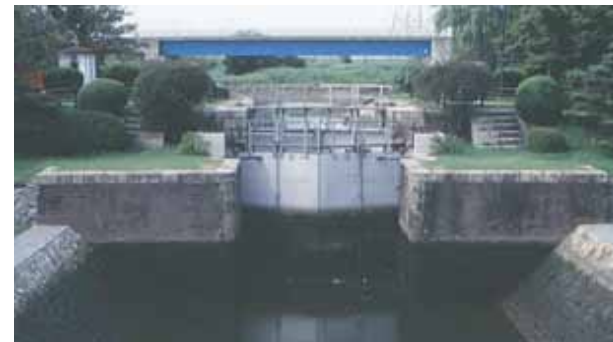
■木曾川の閘門 閘室側からの眺め(出典13-18)
