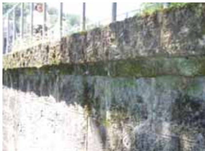
袖堤天端部のデザイン(詳細)(出典25-14) 天端石は1個の石が2段で張り出す形に加工されている。
