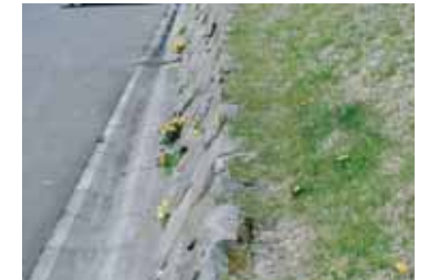
■天端工のコンクリート部分を若干低く施工し、その上部に土を入れ植栽することによって天端のコンクリートを隠している。(出典27-3)
