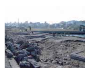
■新波止施工時写真 (出典6-13)
