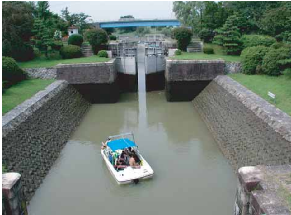
■船頭平閘門の全景(出典13-1)
