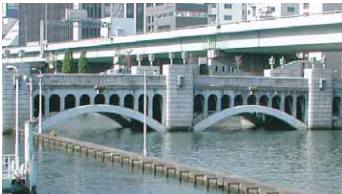
■堂島川可動堰 (昭和4年、写真:出典26-21、図:出典26-22) ラジアルゲート(テンターゲート)橋版の下に門扉が入り、上部に門が持ち上がらない。
