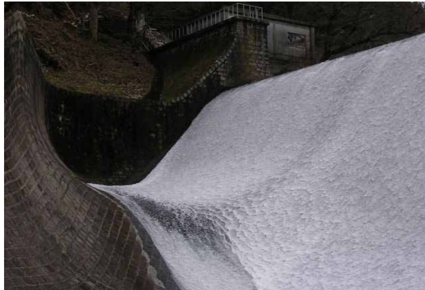
右岸側壁部の造形(出典25-11)
