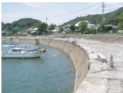
■湾曲した石積護岸と背後緑地 (出典2-15)
