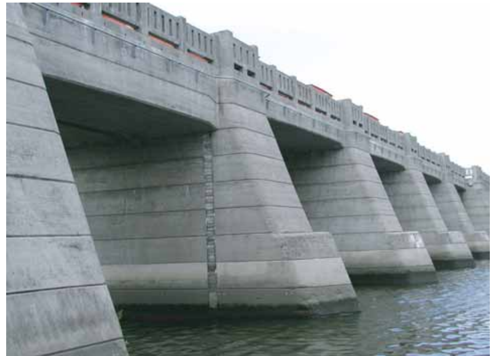
■コンクリートでできた堰柱 (出典14-15)
