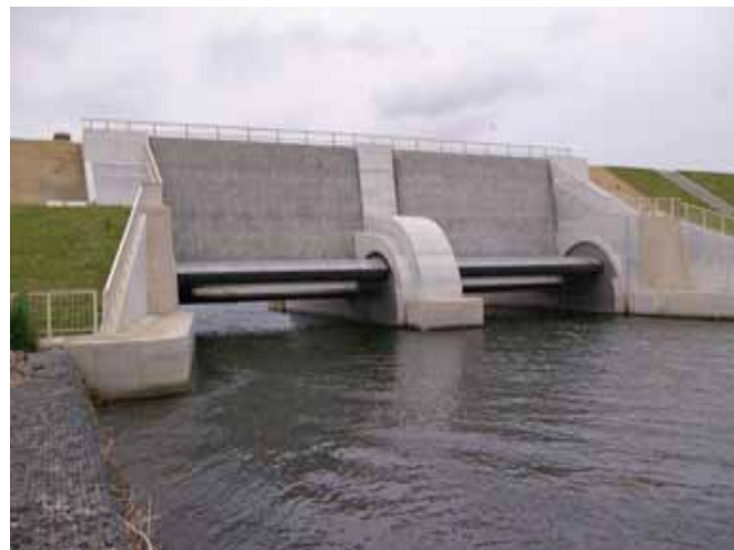
鴉波水門上流側(出典15-12)
