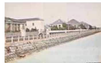
■海岸通り時代の石積み護岸（出典4-11）
