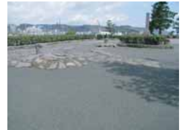
■石畳の不陸調整部と間詰め舗装（出典6-20）
