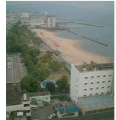
■潜堤、離岸堤等により人工海浜を造成した例（別府海岸）（出典5-6）
