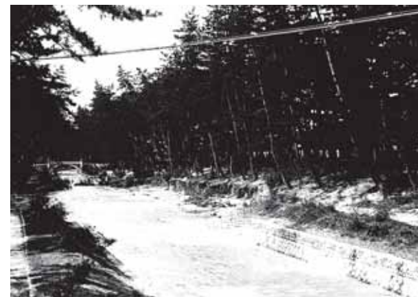
■阪神大水害(昭和13年)時の夙川の被害状況(出典4-15)
