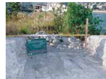
■新波止天端部の試掘写真 (出典6-12)
