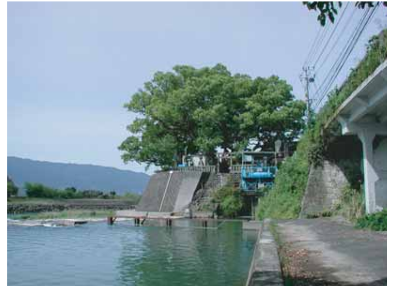
■堀川用水の取水口(出典17-8)
