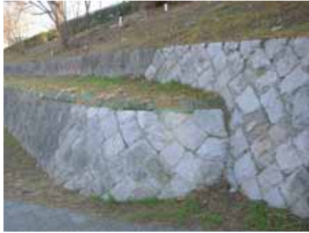
■京都府・鴨川(出典27-6) 護岸同士の取り付けが丁寧。
