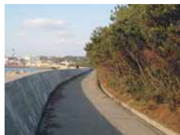
■ 西之表港の飛沫防止帯 (出典4-7) 幅3mで防風効果をあげるため、自生種マルバニッケイを密植し、中心にクロマツを配した高密度な植栽帯となっている。
