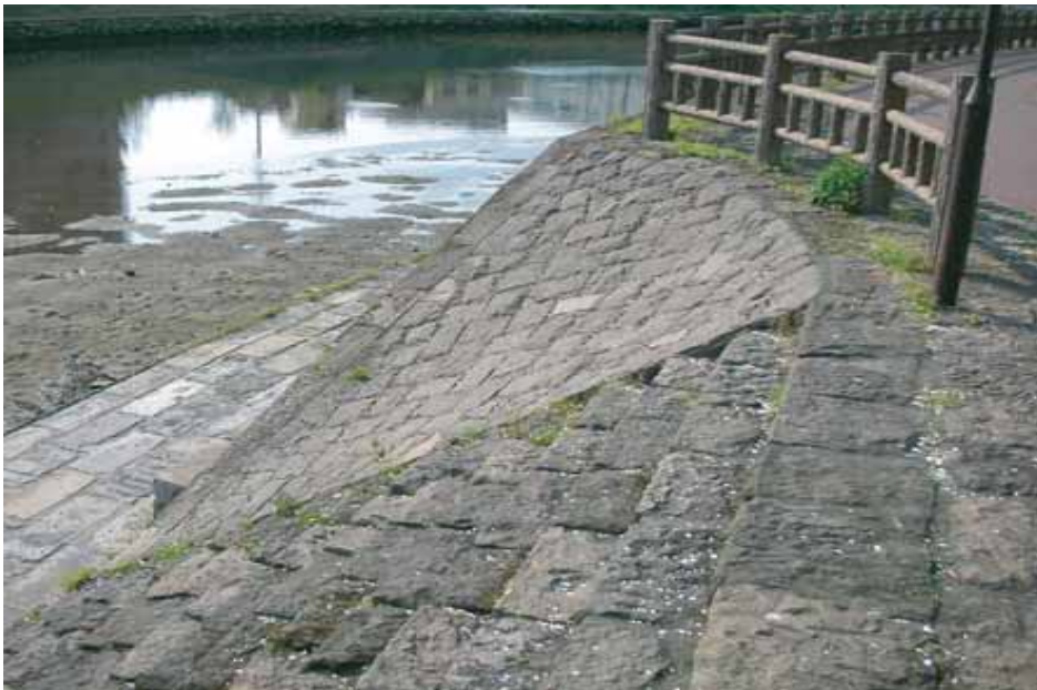
■鹿児島県・甲突川(出典27-30) 護岸部と階段部とのすり付けを曲線として処理している。
