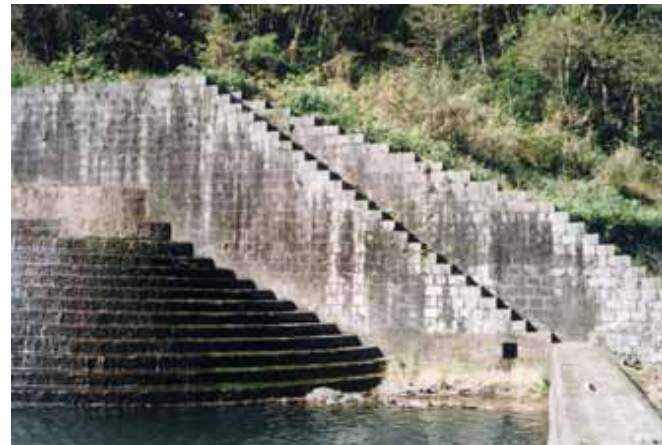
左岸階段部のデザイン(出典25-15) 堰堤直下の副ダムに至る階段とさらに下流に至る階段が組み込まれている。
