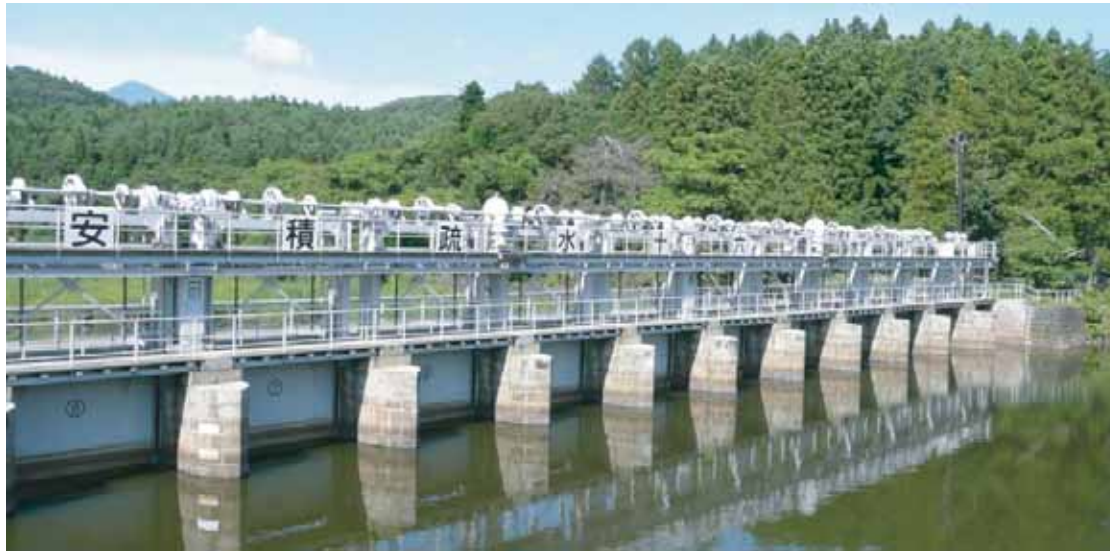
■現在の安積疏水の十六橋水門(開閉装置はストーンローラーゲート、出典26-1)
