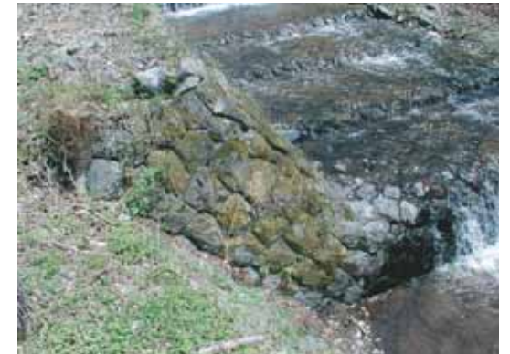
■曲線で処理された袖壁部と落差部(出典19-2)
