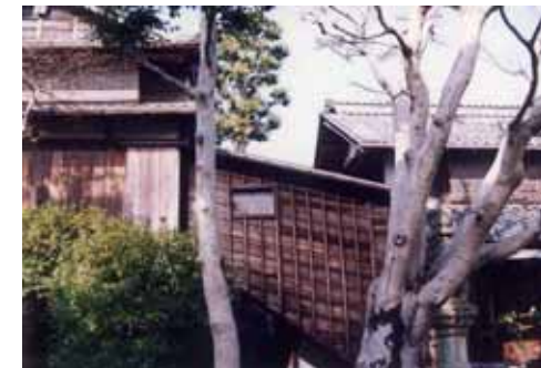
水屋に見られる洪水対応の知恵(出典28-14) 盛土された敷地の上に立つ母屋から、さらに一段高い塚の上に立つ蔵に避難するための階段が設けられている。水屋には避難用の船を準備している場合も多い。
