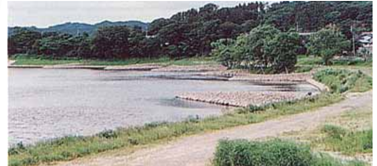
施工後3ヶ月経過(1995年6月)(出典11-7)
