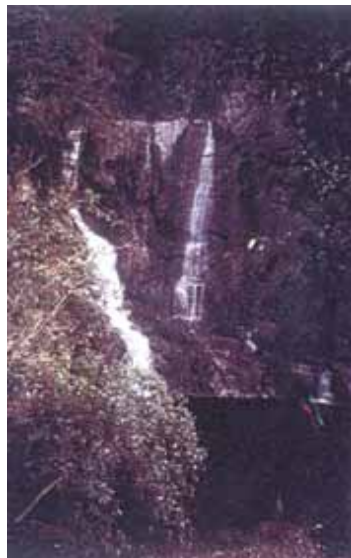
自然の岩盤を利用した余水路流出口 (出典22-8)
