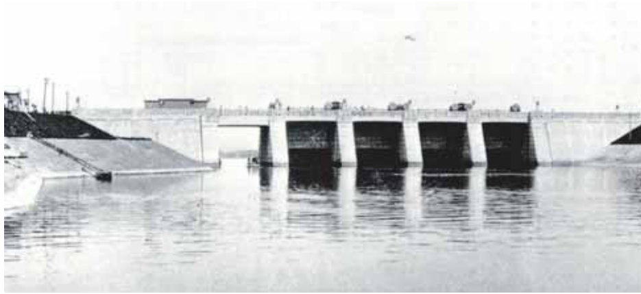
■建設当時の水門全景(下流より、出典14-5)
