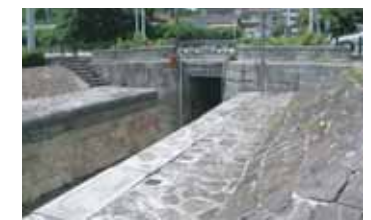
■ 水路部の石積と橋 (出典2-8)
