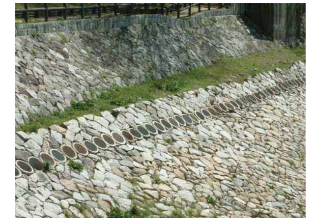
貯水池の護岸(出典23-16) 護岸の一部に石臼がはめ込まれている。
