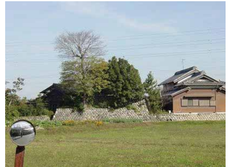
水屋(出典28-13) 家の周りを石垣で囲い盛土した上に住居を構える水屋。生垣は水害防備林と同じ役割を有する
