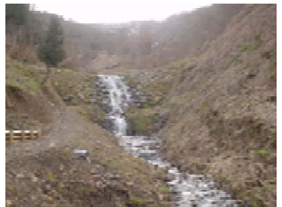
69 赤谷川・アカタン砂防堰堤群
