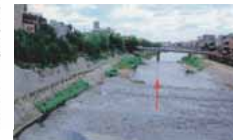
■左岸改修後の四條駅周辺の 鴨川の写真(出典5-8) 昭和10年に計画された改修 が、平成11年になり実現した。
