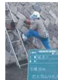
■半練護岸の工事(出典6-9)
