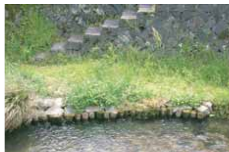
■現在の高水敷の状況(出典6-11)
