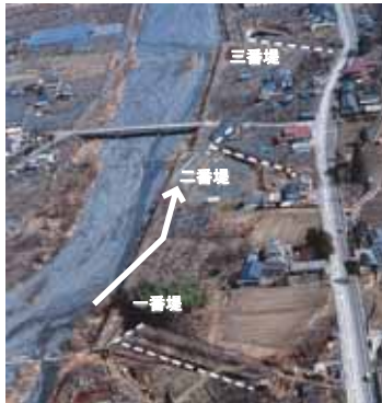
■石積み出し (A地点) (左上、出典1-5) 二番堤の近影写真(高さ約3.3m)。 (左下、出典1-6) 扇頂部の流れを北側に安定させる。
