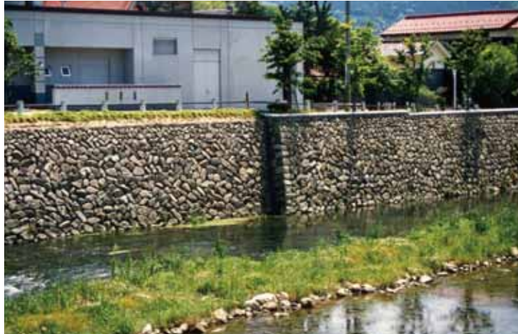
護岸の深目地仕上げ(出典9-11)
