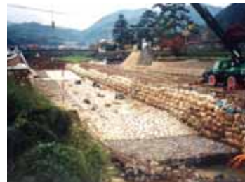
落差工の施工状況(出典9-14)
