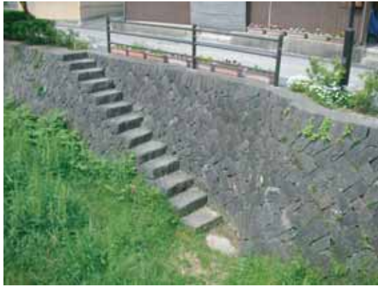
■下流側に向けて設置されている階段(出典6-13)
