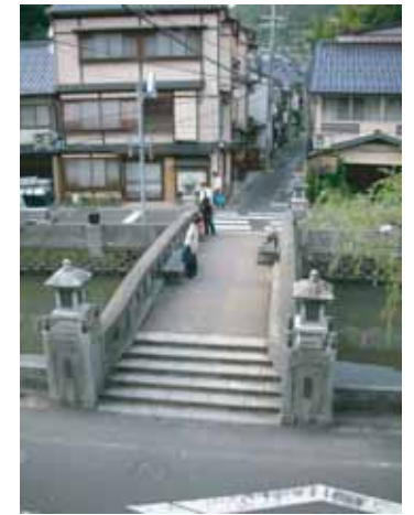
■桃島橋・上流からの俯瞰(出典3-11) 橋上には休憩用のベンチが設置してある。
