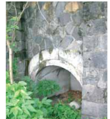
■廃止された岩穴水門(I地点、出典1-15)
