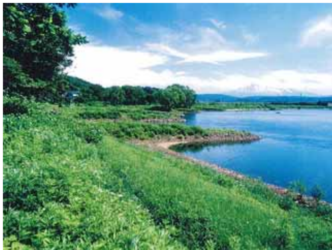
二十六地区水制工群全景(出典11-1)
