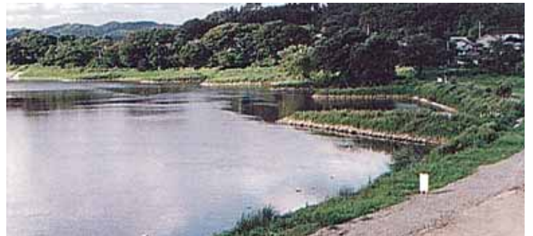
施工後1年6ヶ月経過(1996年9月)(出典11-8)
