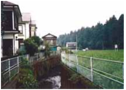
整備前の状況(出典12-5)
