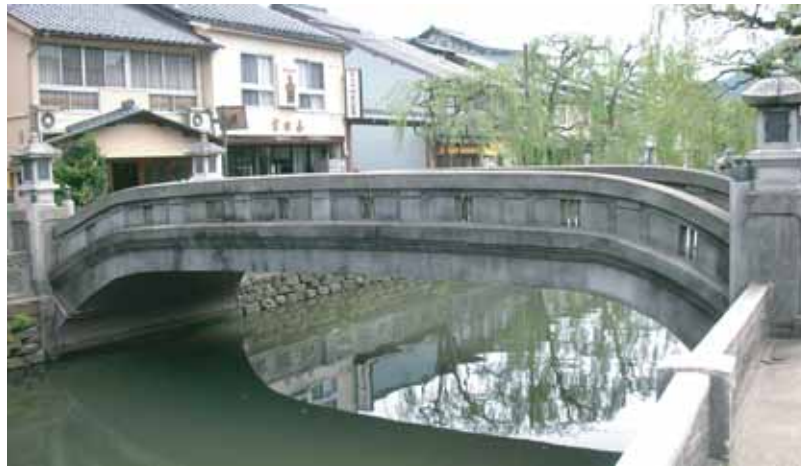
■桃島橋・上流からの全体(出典3-10) 流下断面確保のために弓形の形状となっている。
