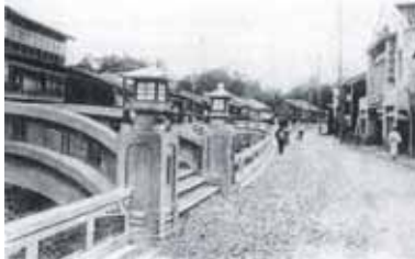
■完成直後の弓形橋と特殊堤(出典3-3)
