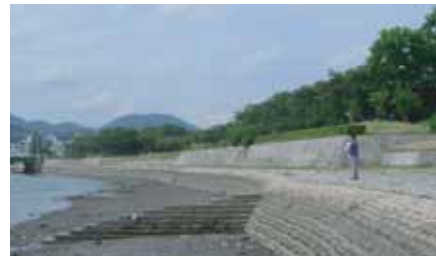
■階段状の水制(B)(下流側、出典7-15)
