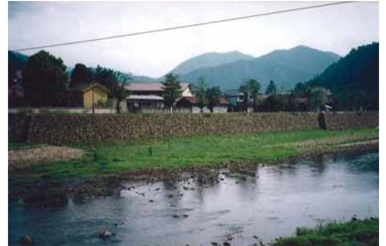
低水護岸部の状況(出典9-15)
