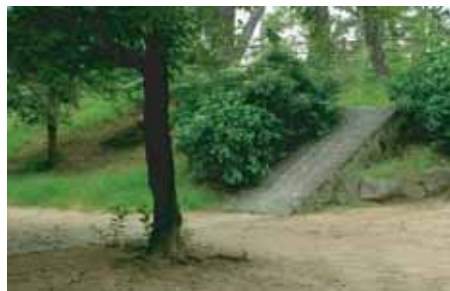
■ 園地に設置されている河川構造物(出典4-10)
