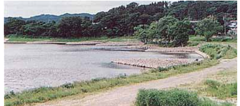
施工後3ヶ月経過(1995年6月)(出典11-7)
