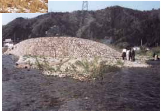
分派部の状況(左上が上流側からの全景)(出典8-10)
