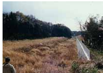
整備前の状況 (出典12-9)
