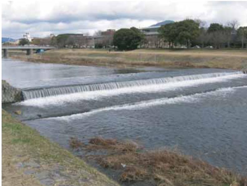
■鴨川本川にある床止堰堤(出典5-14)
