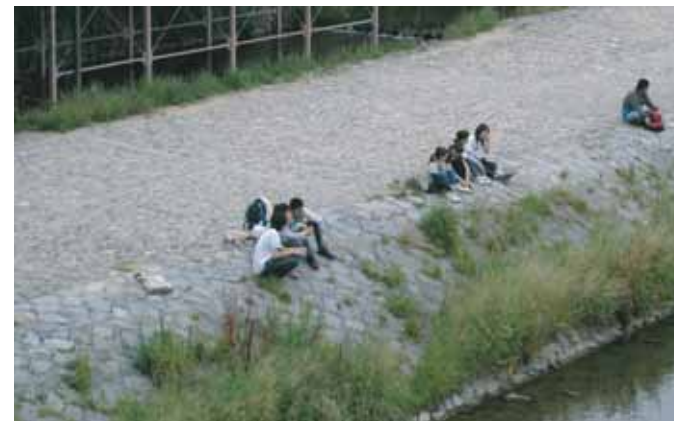
■四條大橋付近の巻天端
