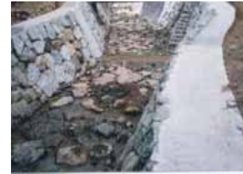
■切天端の場合、天端工がコンクリートのままであると目立ち、周囲の景観に馴染まない。(出典27-2)
