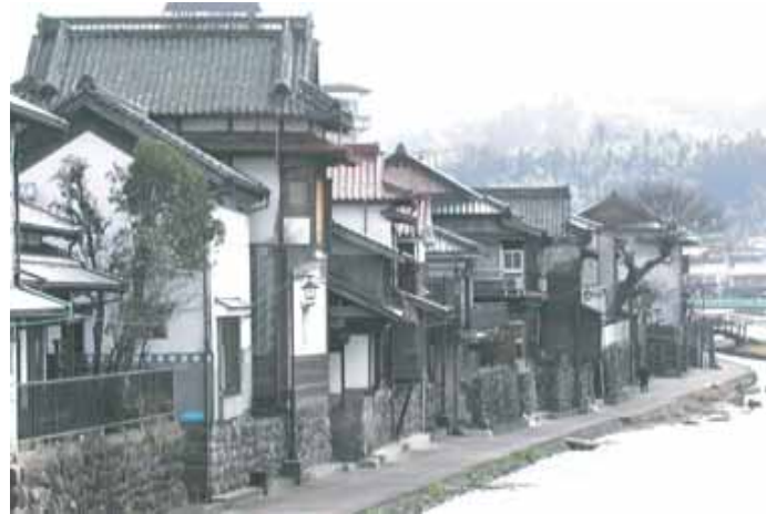
■大分県・庄手川(出典27-9) 護岸(家の基礎部)の端部処理が美しいため、端部が多く見える雁行形状になっていても違和感がなく、護岸にアクセントを与え、落ち着いた景観を生みだしている。なお、水際部の構造物は、昭和40年代に根固として設けられたものである。
