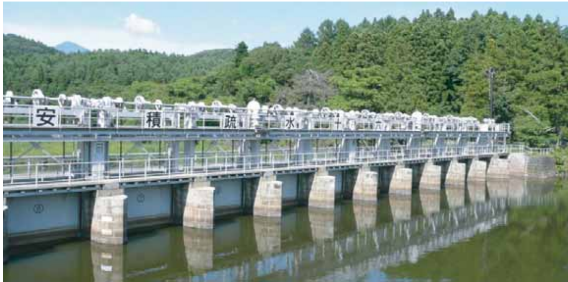
■現在の安積疏水の十六橋水門(開閉装置はストーニーゲート、出典26-1)
