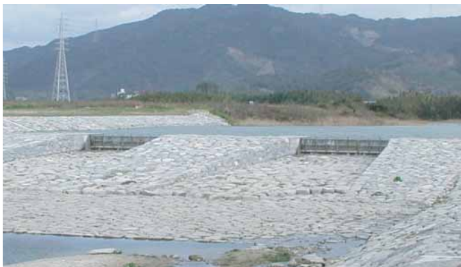
■大井手堰 (平成17年、写真:出典26-17、図:出典26-18) 油圧シリンダを利用した起伏ゲート
