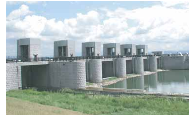
■平成に改築された大河津分水路・洗堰の油圧シリンダー式の水門(出典26-10)
