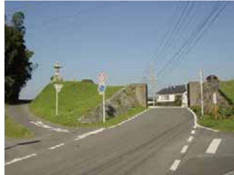
輪中堤の切割り(出典28-11) 輪中堤の中と外を結ぶ道路を通すために設けられた輪中堤の切割り
