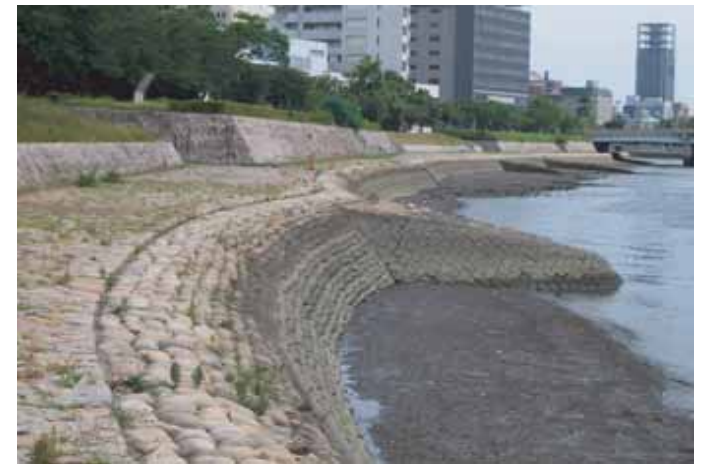
■広島県・太田川(出典27-10) 護岸天端、護岸端部にも丁寧に作りあげているため、構造物に連続性が感じられ、護岸が川と背後の市街地を分断する構造物となっていない。特に、水際部の玉石構造と、天端部の雑割張石構造との境にわずかな段差(5cm)をあえて設け、エッジを際立たせることにより素材の加工が異なっていることに違和感を感じさせず、景観全体に縮まり与えている。
