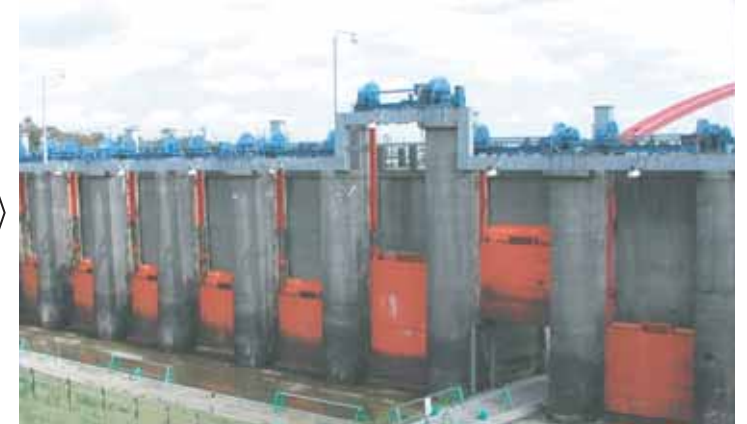
■戦後に各門が電動巻き上げ機を持つものとなった大河津分水路・洗堰(出典26-9)
