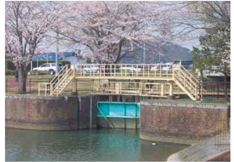
■現在の石井閘門(開閉装置はマイターゲート、出典26-2)
