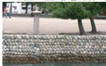
■厳島港の野面石積み護岸(出典3-11)
