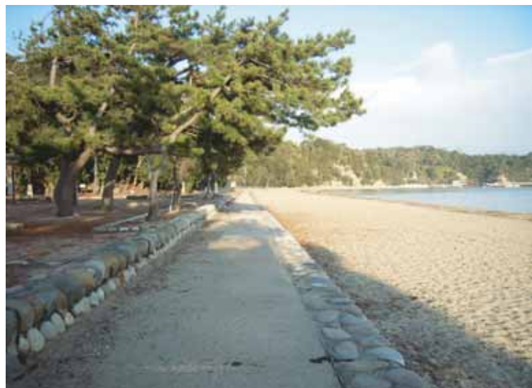
■護岸部分(出典3-9) パラペット背後に設置した植栽樹の一列松により背後の公園と連続
