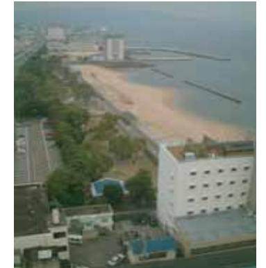
■潜堤、離岸堤等により人工海浜を造成した例（別府海岸）（出典5-6）
