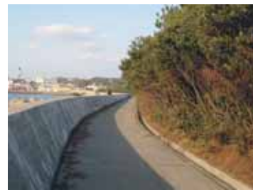
■ 西之表港の飛沫防止帯 (出典4-7) 幅3mで防風効果をあげるため、自生種マルバニッケイを密植し、中心にクロマツを配した高密度な植栽帯となっている。
