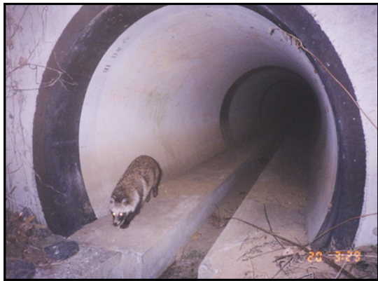
写真1 北関東自動車道の動物横断兼用用水路
