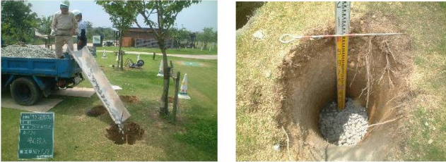
(人力掘削による改良)
