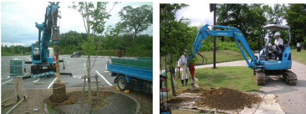
(機械掘削による改良)
