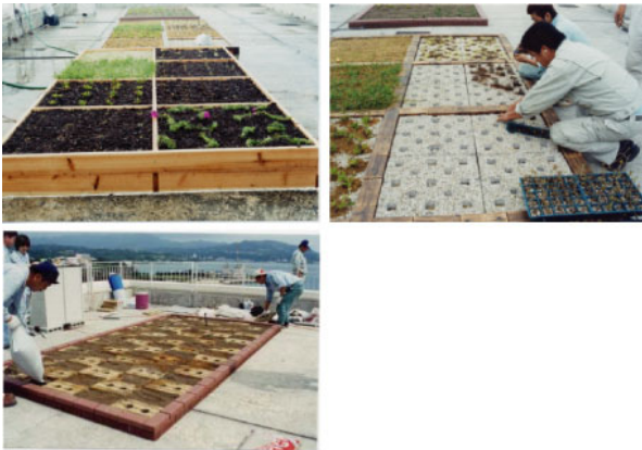
写真1．屋上緑化試験区の構造（左上：試験区A、右上：試験区B、左下：試験区C）
